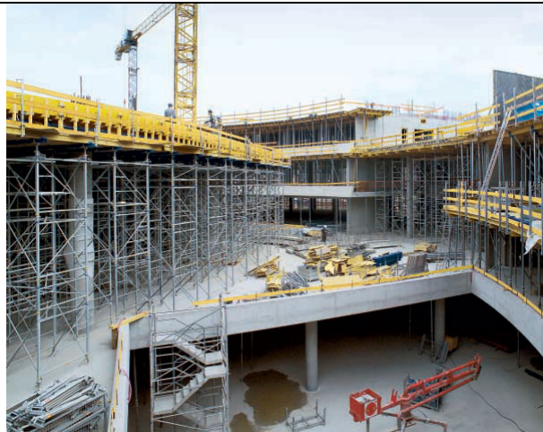
Slika: Stolpi Staxo (Doka opažni katalog, 2004, str.: 220)
