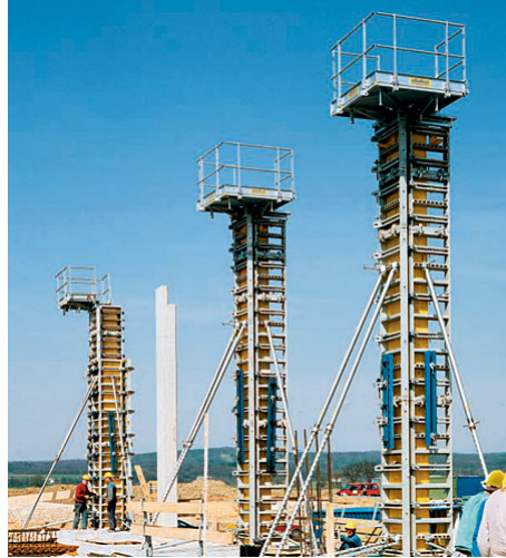
Slika: Opaž stebra ALU (Doka opažni katalog, 2004, str.: 141)
