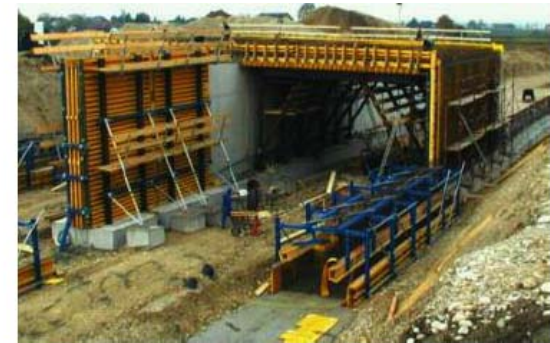
Slika: Gradnja se izvaja znotraj gradbene jame z nagnjenimi brežinami (Doka - Tunnelschalungen, 2005, str.: 17)
