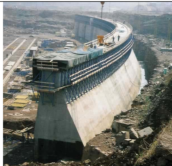
Slika: Opaž za pregrado (Doka opažni katalog, 2004, str.: 210)
