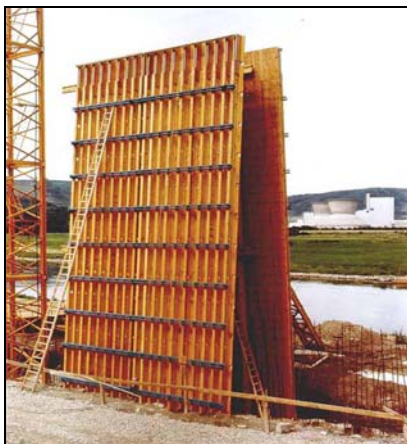
Slika: Sekundarna konstrukcija iz lesenih nosilcev pri opažu sten (Qualität und Sicherheit, 2001, str.: 24)
