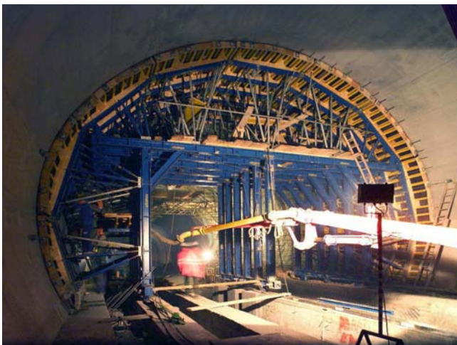
Slika: Betoniranje predora z betonsko črpalko (Doka - Traggerüst SL-1, 2005, str.: 2)
