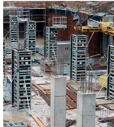
Slika: Opaž stebra Framax (Doka opažni katalog, 2004, str.: 122)
