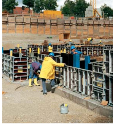
Slika: Stenski opaž Frami (Doka opažni katalog, 2004, str.: 64)
