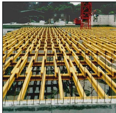
Slika: Sekundarna konstrukcija iz lesenih nosilcev pri opažu plošč (Dokaflex 124, 2001, str.: 41)
