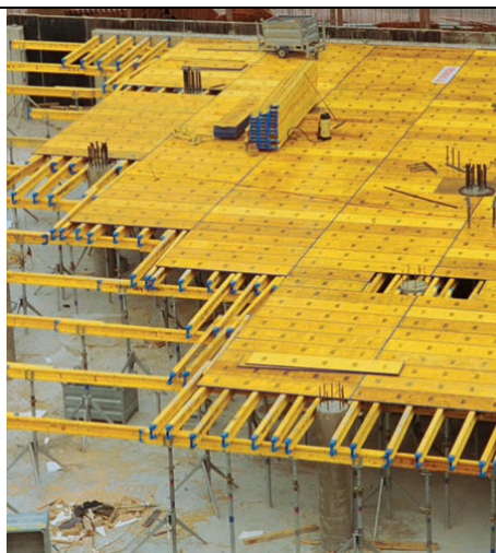
Slika: Dokaflex 1-2-4 (Doka opažni katalog, 2004, str.: 173)
