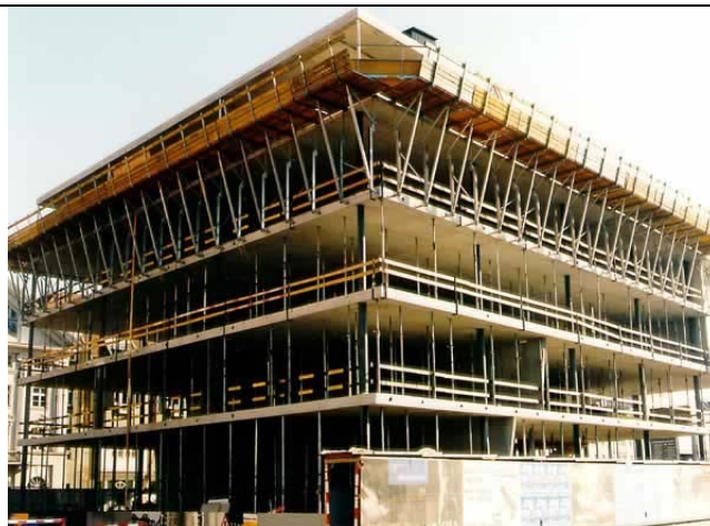
Slika: Odri K (Doka opažni katalog, 2004, str.: 271)
