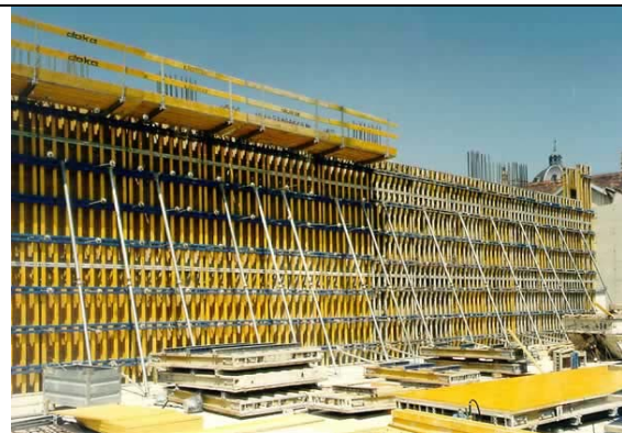
Slika: Stenski opaž FF20 (Doka opažni katalog, 2004, str.: 97)
