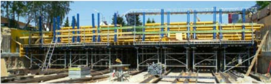
Slika: Podpiranje plošče s podpornimi stolpi (Doka - Tunnelschalungen, 2005, str.: 38)
