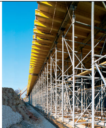
Slika: Stolpi d2 (Doka opažni katalog, 2004, str.: 228)
