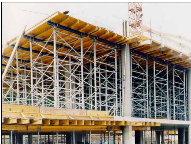
Slika: Primarna konstrukcija iz podpornih stolpov jeklenih profilov (Staxo, 2001, str.: 1)
