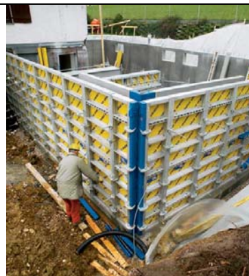
Slika: Stenski opaž Alu - Framax (Doka opažni katalog, 2004, str.: 42)
