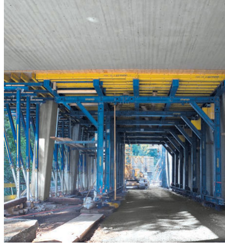
Slika: Stolpi SL-1 (Doka opažni katalog, 2004, str.: 238)
