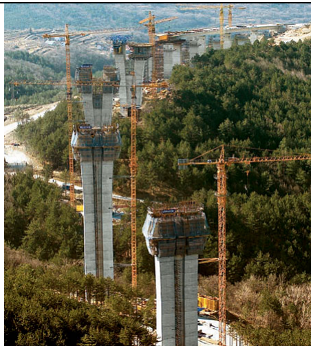
Slika: Samoplezajoči opaž SKE (Doka opažni katalog, 2004, str.: 191)
