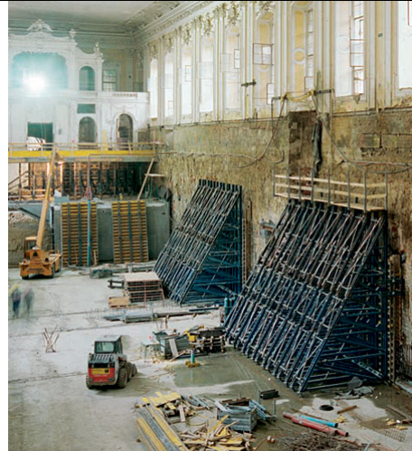
Slika: Konzole enostranskega opaža (Doka opažni katalog, 2004, str.: 254)
