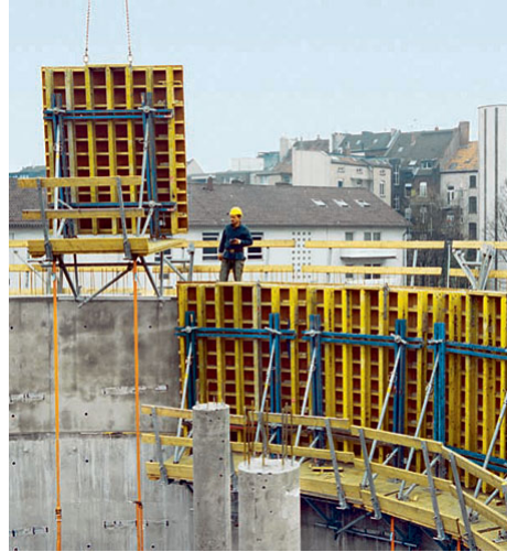
Slika: Plezajoči opaž K (Doka opažni katalog, 2004, str.: 204)
