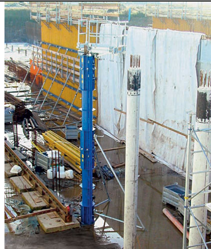
Slika: Opaž stebra RS (Doka opažni katalog, 2004, str.: 144)
