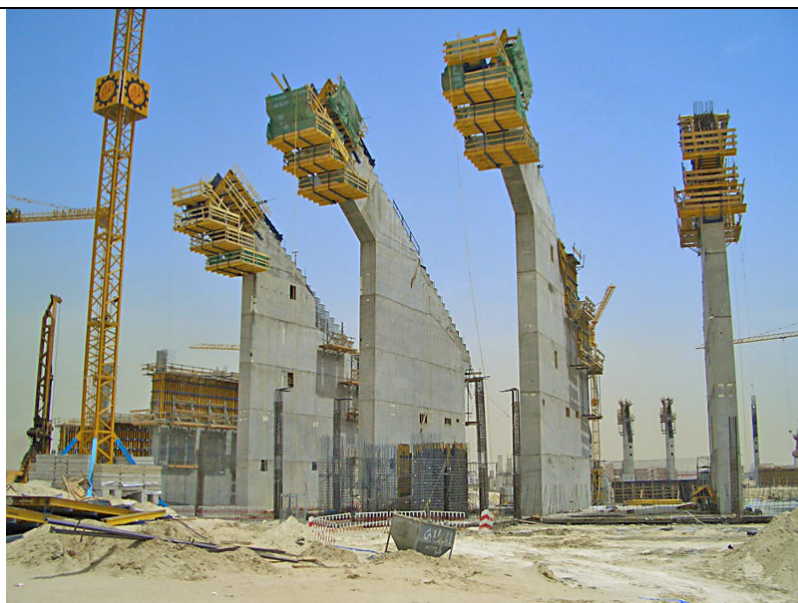
Slika: Plezajoči opaž 150F (Doka opažni katalog, 2004, str.: 200)
