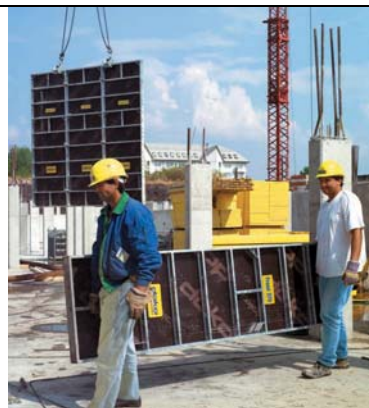
Slika: Stenski opaž Frami 270 (Doka opažni katalog, 2004, str.: 72)
