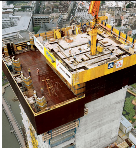
Slika: Ploščad SCP (Doka opažni katalog, 2004, str.: 196)
