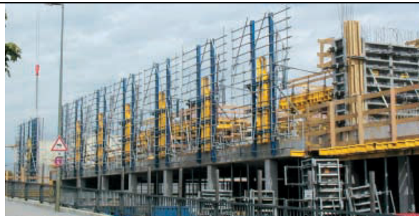
Slika: Fasadni opaž Top 50 (Doka opažni katalog, 2004, str.: 116)
