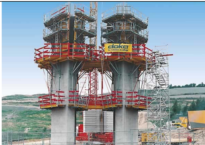
Slika: Plezajoči opaž MF (Doka opažni katalog, 2004, str.: 182)
