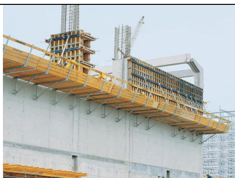
Slika: Vezni vijaki/obešalni konusi (Doka opažni katalog, 2004, str.: 294)
