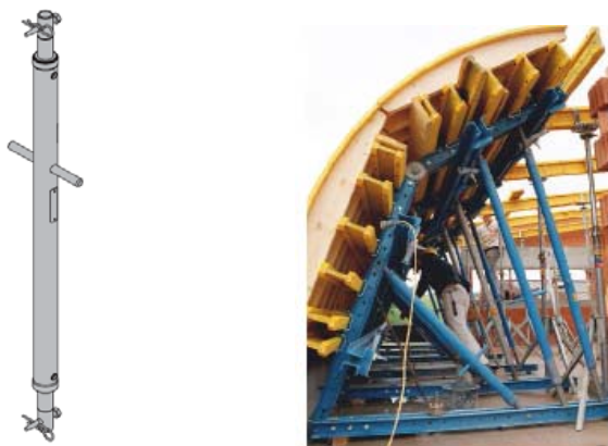
Slika: Vijačne opore, ki povezujejo nosilno konstrukcijo SL-1 in ločne opažne elemente Top 50 (Doka - Trägerschalung Top 50, 2006, str.: 46)
