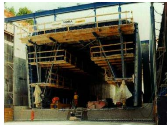
Slika : Gradnja se izvaja znotraj gradbene jame, ki je zavarovana s zagatnimi stenami (Doka - Tunnelschalungen, 2005, str.: 17)
