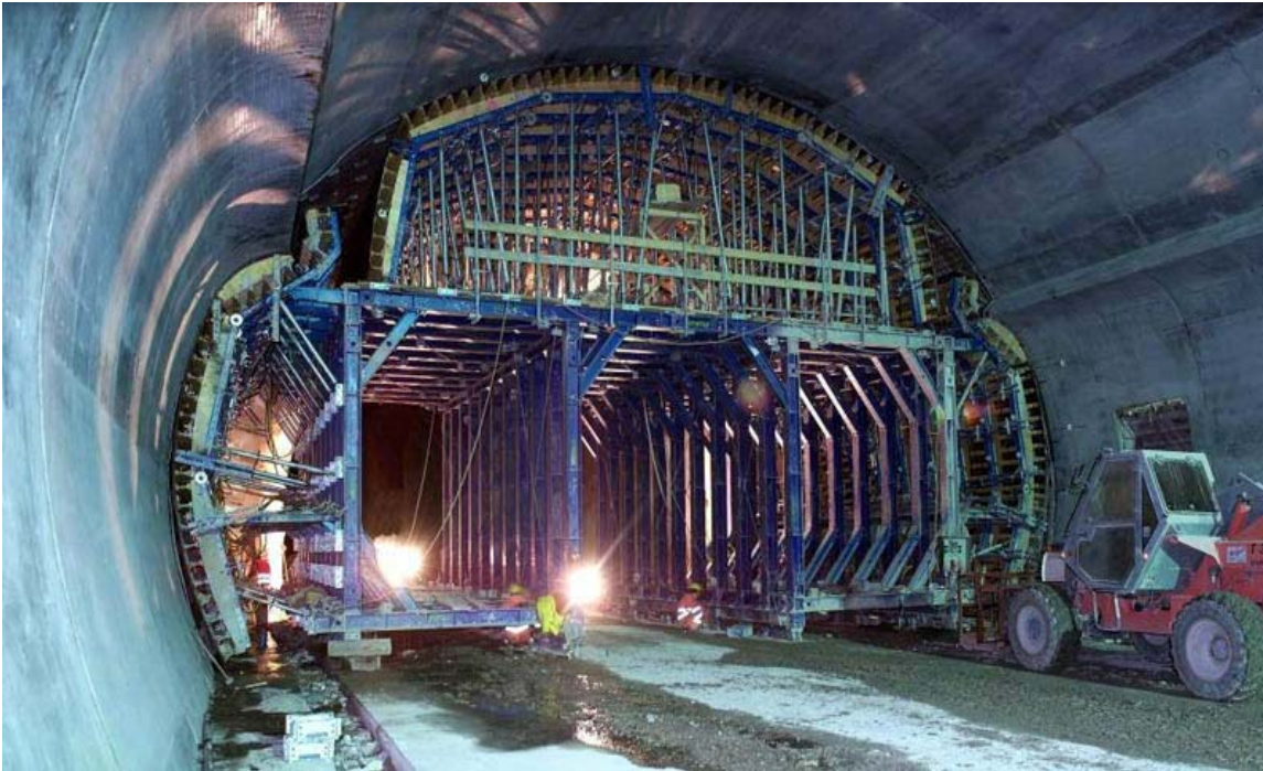
Slika: Betoniranje sten in plošče predora skupaj (Doka - Traggerüst SL-1, 2005, str.: 5)
