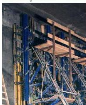
Slika: Enostranske bočne opore (Doka - Tunnelschalungen, 2005, str.: 44)
