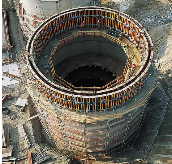
Slika: Okrogli opaž H20 (Doka opažni katalog, 2004, str.: 106)
