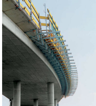
Slika: Konzole robnega venca (Doka opažni katalog, 2004, str.: 246)
