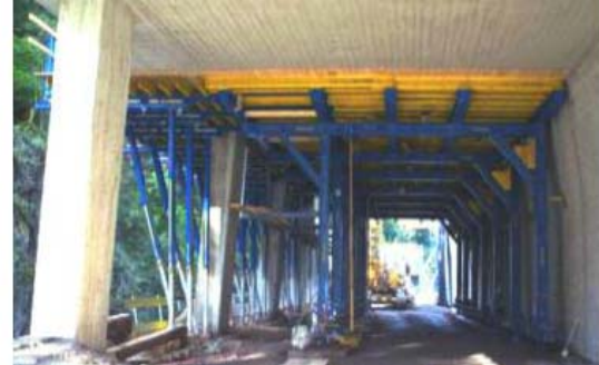
Slika: Gradnja se izvaja brez gradbene jame (galerije). Po izgradnji betonsko konstrukcijo prekrijemo z zemljino (Doka - Tunnelschalungen, 2005, str.: 17)
