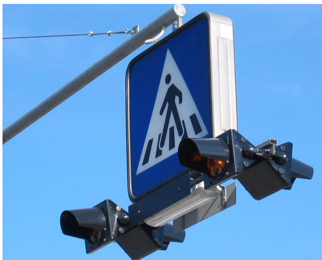
Slika 34: Prometni znak z notranjo LED osvetlitvijo, dodatnima svetlobnima utripalcema in natrijevo svetilko
