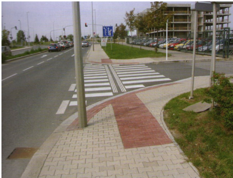
Slika 45: Primerno označevanje prehoda za pešce s taktilnimi oznakami kontrastnih barv (Čutim, vidim, zmorem)
