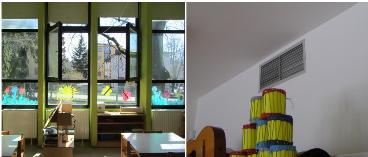
Slika 8: Primer naravnega prezračevanja igralnice z odpiranjem oken (levo) in mehanskega prezračevanja s centralnim prezračevalnim sistemom (desno).
