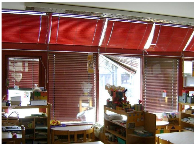
Slika 11: Poškodovana in neuporabna senčila v igralnici, ki so velikokrat vzrok za slabo svetlobno udobje.
