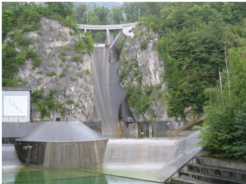
Slika 8: Pregrada na Savi – hidroelektrarna Moste (Kolman, 2012)
