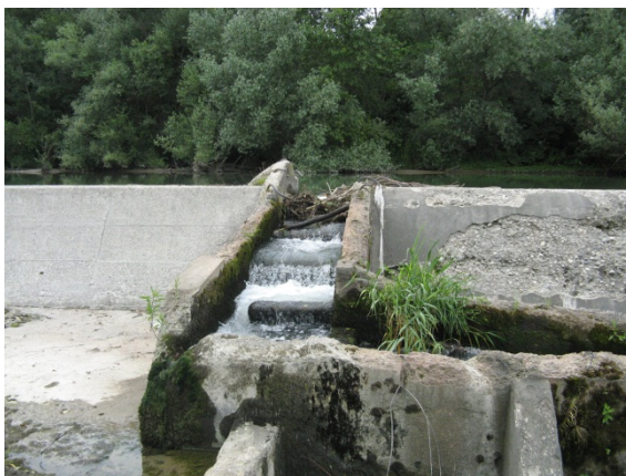
Slika 26: Ribja steza na jezcu v Goričanah na Sori (Kolman, 2012)
