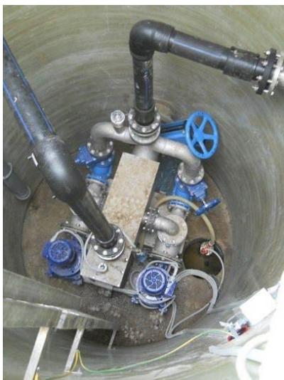
Slika 15: Črpalni jašek Brezno – primer črpalnega jaška ( www.regeneracija.si , 12.9.2013)
