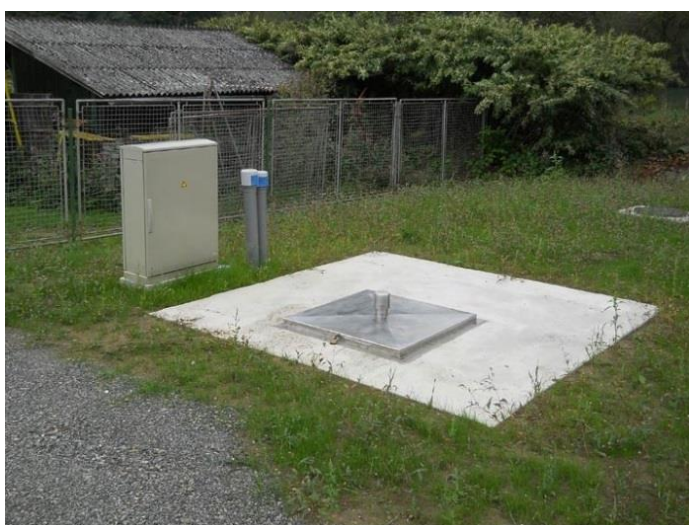
Slika 16: Primer črpališča Brezno ( www.regeneracija.si , 12.9.2013)
