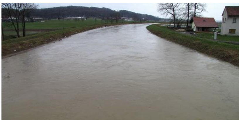
Slika 17: Visokovodni nasip reke Ščavnice v Cezanjevcih.
