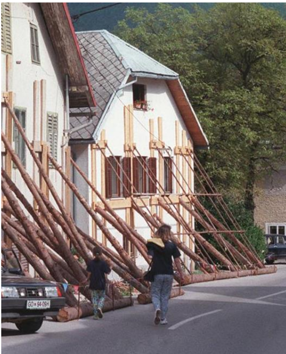
Slika 31: Obravnavan objekt, podprt po potresu 2004 v Posočju ( www.slovenskenovice.si , 2013)
