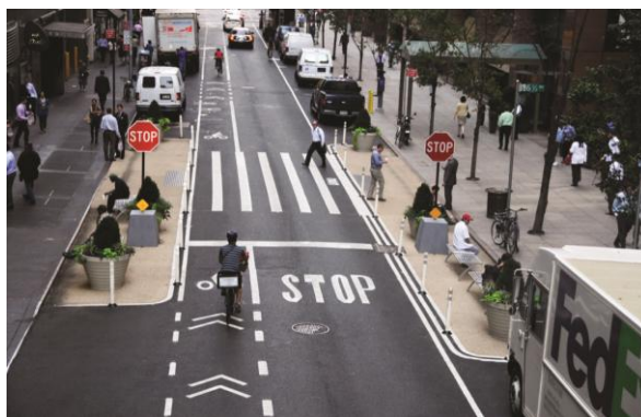
Slika 15: Razširitev pločnika izven križišča na prehodu za pešce
