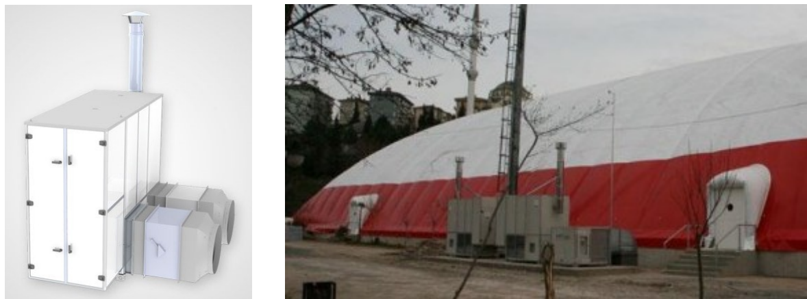
Slika 19: Levo je primer strojne enote z ogrevanjem na plin (Apen Group, 2014) desno pa njena namestitvev na objekt (Teloni Abiti, 2014).
