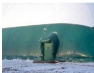
Slika 69: Prikaz gubanja priklopov na konstrukciji (Teloni Abiti, 2014).
