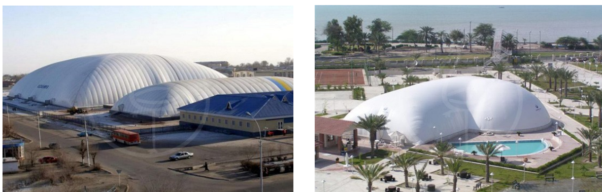
Slika 18: Levo sta dve konstrukciji sestavljeni iz cilindra in z zaključki nad pravokotnim tlorisom, ki je najpogosteje uporabljena oblika v praksi, desno pa kombinacija enake oblike s sfero (Plasteco Milano, 2014).
