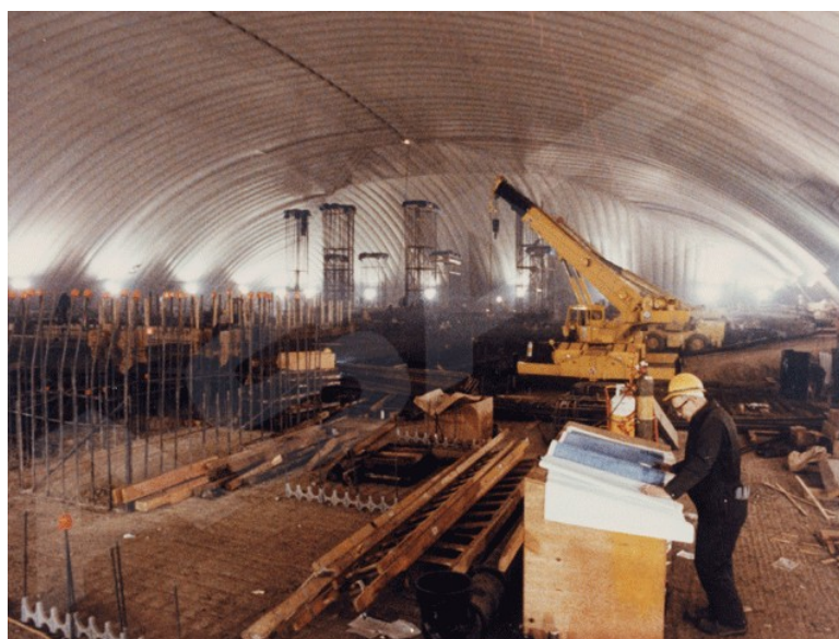
Slika 7: Zračno podprta konstrukcija podjetja ASATI, ki je pokrila celotno gradbišče (ASATI, 2014).
