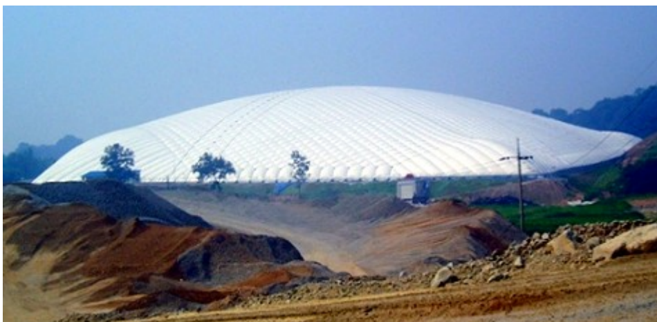
Slika 8: Največja zračno podprta konstrukcija na svetu postavljena leta 2006 v Južni Koreji (Southern Inflatables, 20149)
