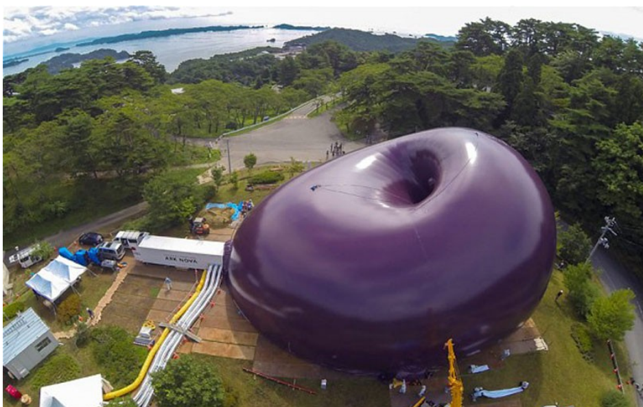
Slika 9: Zračno podprta koncertna dvorana Arc Nova, ki gostuje po delih Japonske, ki jih je prizadel potres in cunami (Azzarello, 2013).
