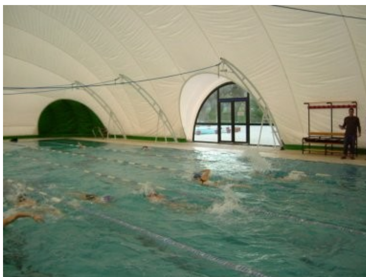
Slika 29: Primer dveh fleksibilnih robov na primeru pokritja bazena (Canobbio, 2003). Prvi je pri odprtini za vrata, drugi pa pri spremembi ukrivljenosti (med zeleno in belo membrano).
