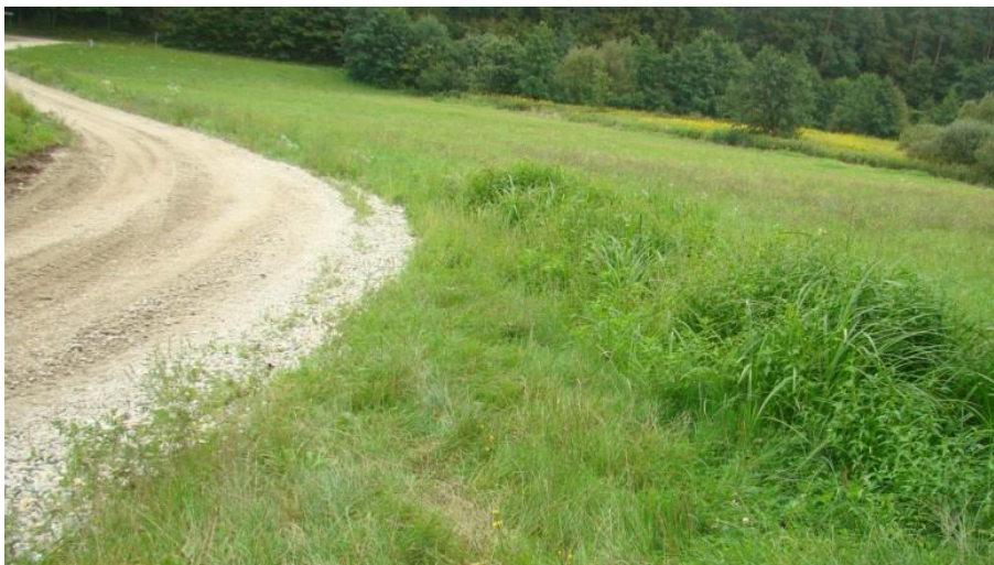
Slika 33: Obstojče makadamsko vozišče izven naselja Bukovnica, slikano v smeri Strehovec (lasten vir).
