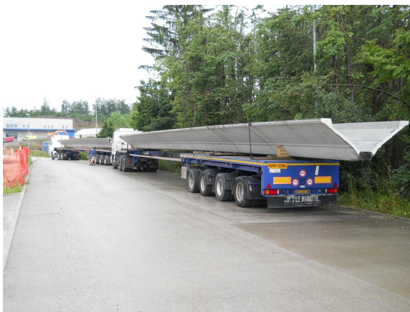
Slika 2: Prednapeti »V« nosilec tipa »Wing100« na gradbišču v Logatcu.
