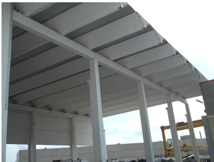
Slika 1: Armirano betonska odprta montažna hala. Strešna konstrukcija je sestavljena iz prednapetih »V« nosilcev tipa »Wing100«.
