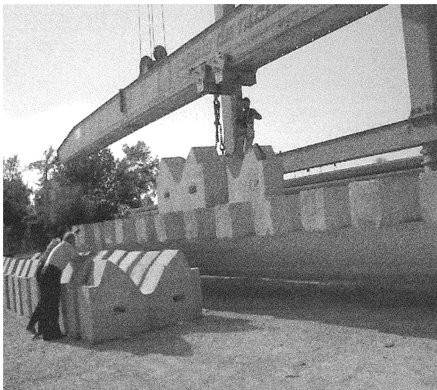
Slika 66: Nanašanje betonskih uteži na primerljiv prednapeti nosilec med obremenilnim preizkusom (Pre-System S.p.A.,2011)
