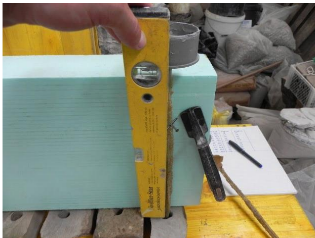
Slika 21: Preverjanje vertikalnosti vgrajenih impregniranih vrvic s posutjem
