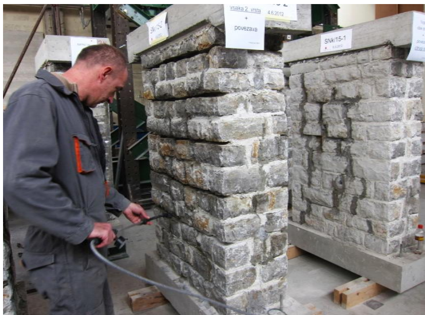
Slika 36: Linijsko injektiran zid pred utrditvijo s steklenimi vrvicami [29]
