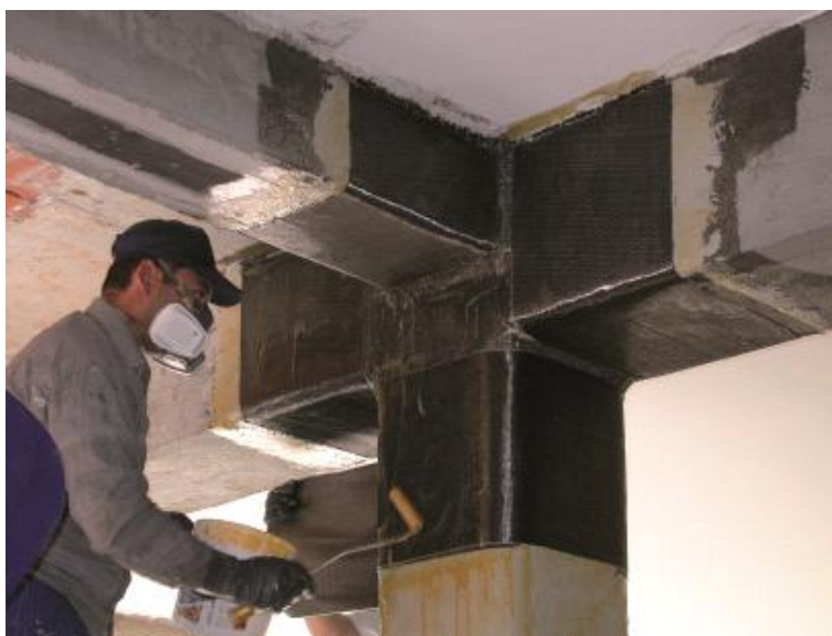
Slika 3: Utrjevanje vozlišč s tkanino iz ogljikovih vlaken [5]
