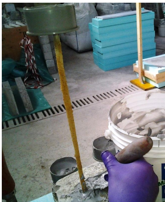
Slika 20: Vgradnja impregnirane vrvice s posutjem v epoksidno malto MapeWrap 12
