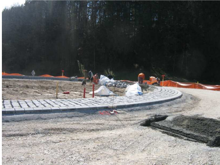
Slika 42: Gradnja krožišča K3
