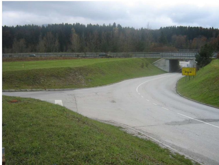
Slika 13: Prvotno stanje križišča K4
