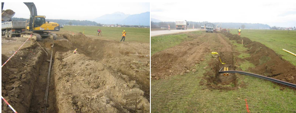
Slika 37: Prestavitev telefonskega optičnega kabla
