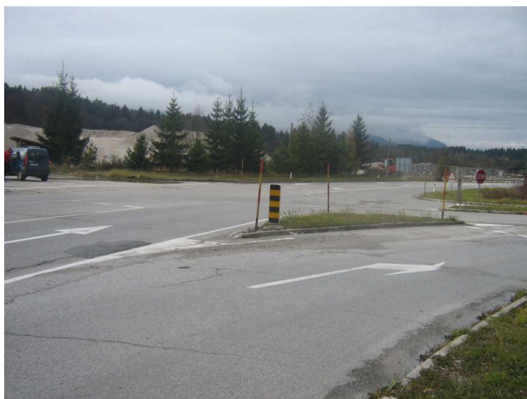
Slika 7: Prvotno stanje križišča K2
