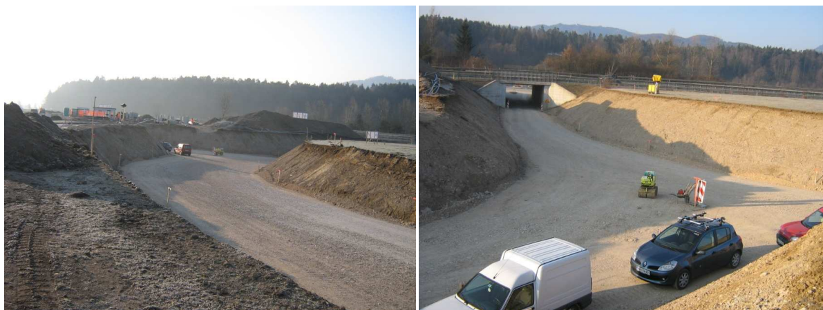
Slika 41: Gradnja deviacije A in križišča 4
