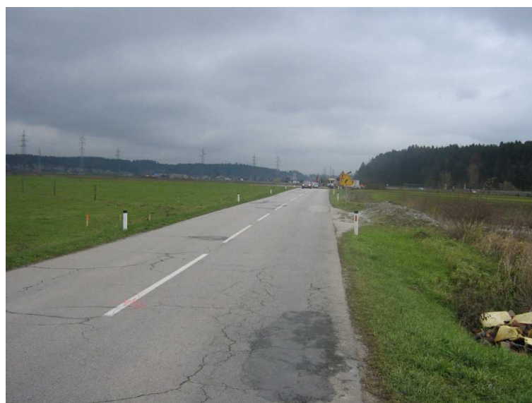
Slika 11: Prvotno stanje križišča K1
