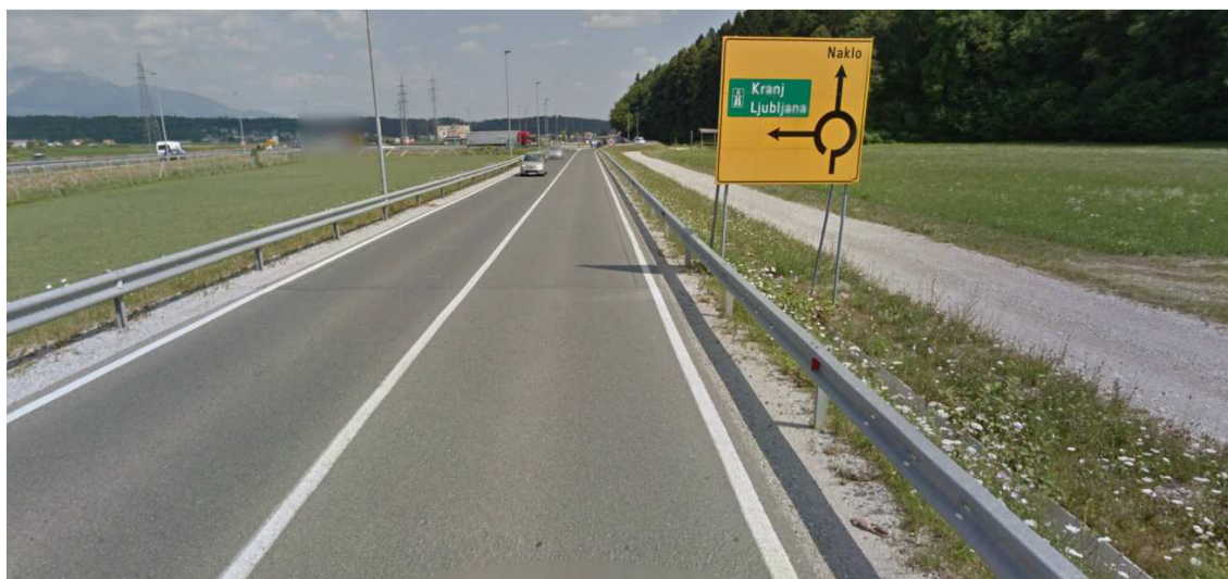
Sliki 19: Končno stanje deviacije F (severni in južni del)
