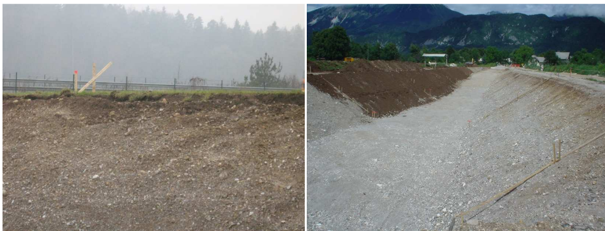
Slika 38: Zakoličba brežin in vmesnih točk
