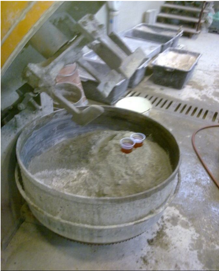
Slika 9: Sestavine za SCC beton v mešalcu, pripravljene za mešanje
