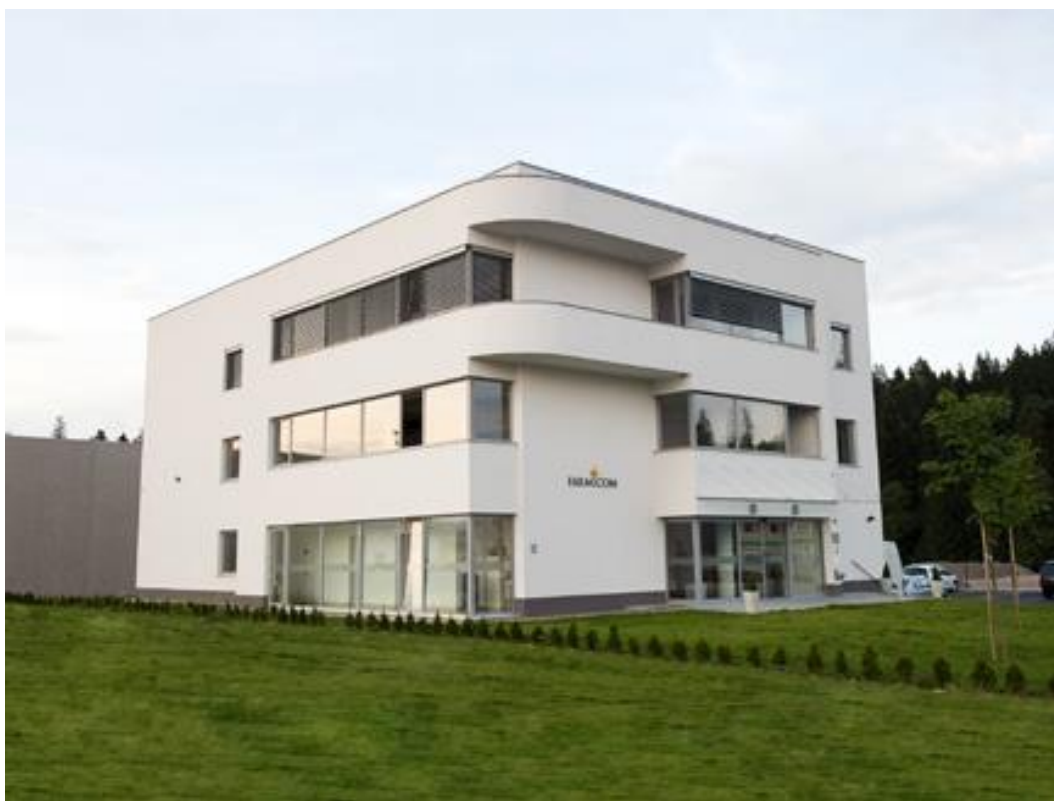
Slika 1: Obravnavan poslovni objekt
