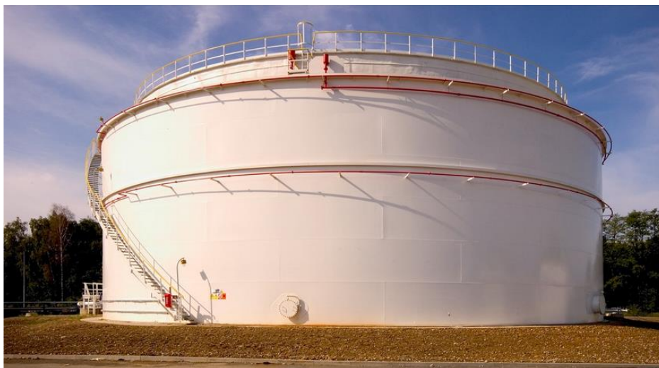
Slika 1.7: Primer rezervoarja s horizontalno ojačitvijo [5]
