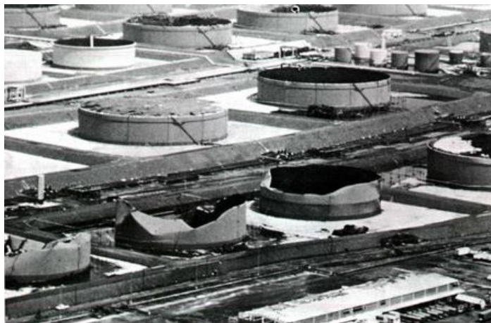
Slika 1.3: Porušitev odprtih rezervoarjev zaradi hurikana Hugo, St. Croix, 1989 [4]
