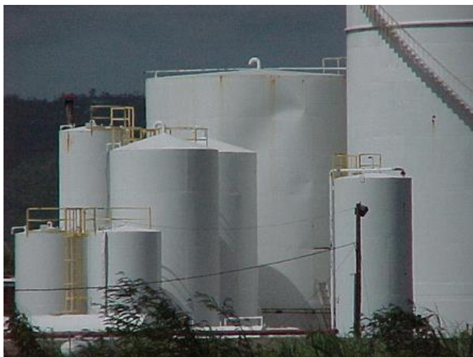
Slika 1.5: Uklon rezervoarja med hurikanom Georges, Puerto Rico, 1998 [4]
