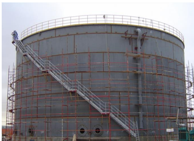
Slika 1.2: Gradnja rezervoarja [3]
