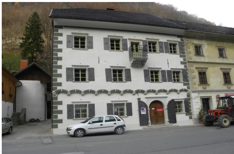
Slika 16: Cestna fasada po končani obnovi fasade
