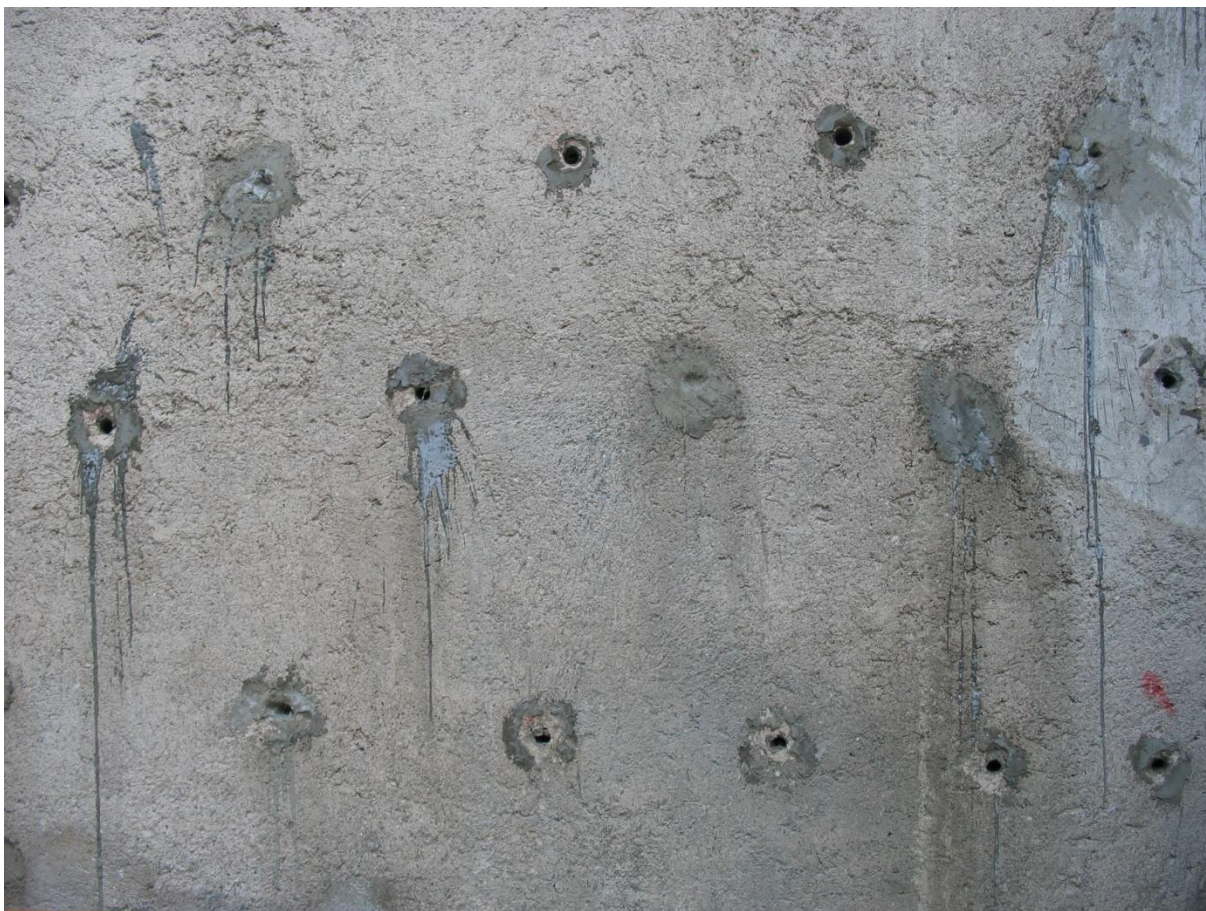
Slika 14: Izvedeno injektiranje zidu
