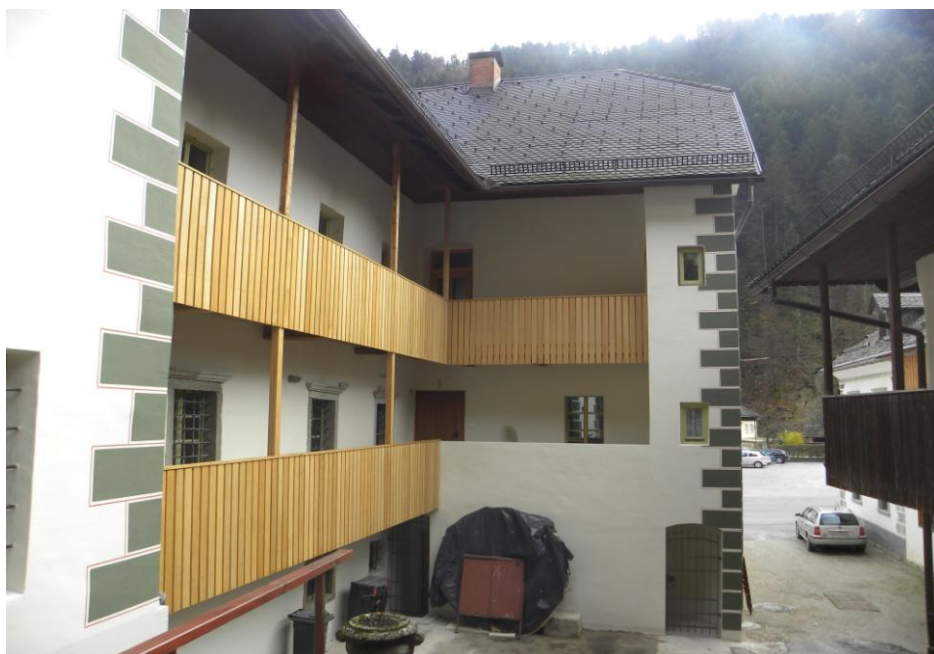
Slika 17: Dvoriščna fasada po končani obnovi fasade
