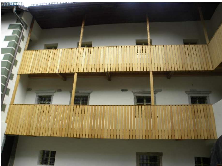
Slika 18: Dvoriščna fasada po končani prenovi fasade in izdelavi novih »gankih«
