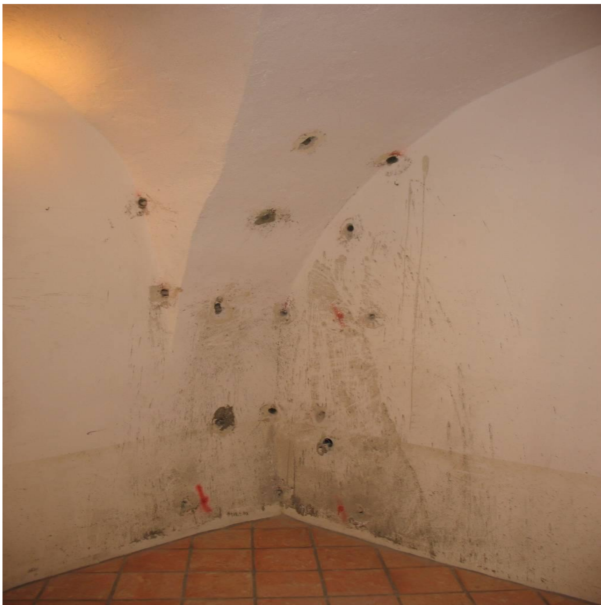
Slika 15: Injektiranje notranjih sten po vodni ujmi leta 2007
