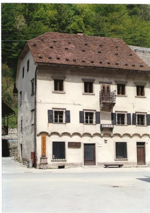
Slika 3: Cestna fasada s pogledom na stransko fasado
