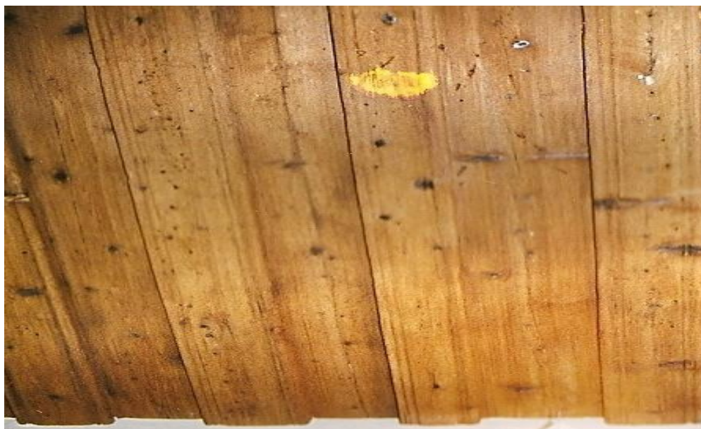
Slika 7: Lesen strop v večnamenskem prostoru pred obnovitvijo
