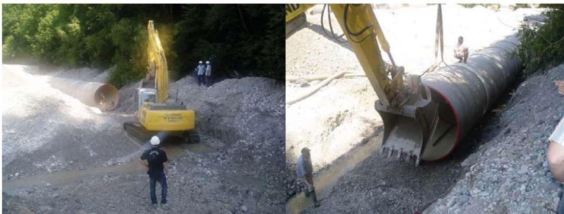
Slika 33: Polaganje cevi v kanal vzdolž derivacije za HE na reki Zilje na avstrijsko Koroškem, [33]
