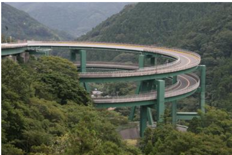
Slika 20: Kawazu-Nanadaru spiralni most pogled od zgoraj
