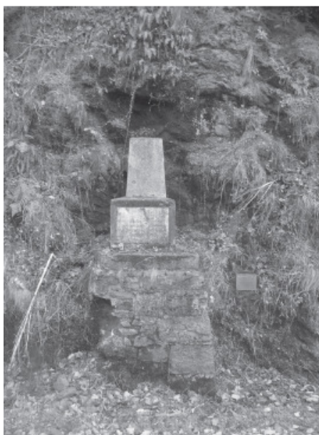
Slika 13: Normalni reper nivelmanske mreže Republike Slovenije (Geodetski vestnik, 2007)
