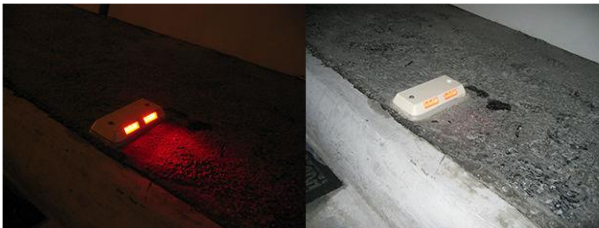
Slika 6: Primer enovrstičnih LED smernikov za povečanje vidnega vodenja prometa v predoru [19].
