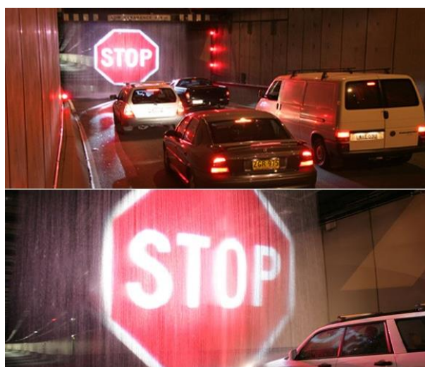
Slika 9: Sistem Soft Stop Laser vision za zaustavitev prometa pred predorom [19].
