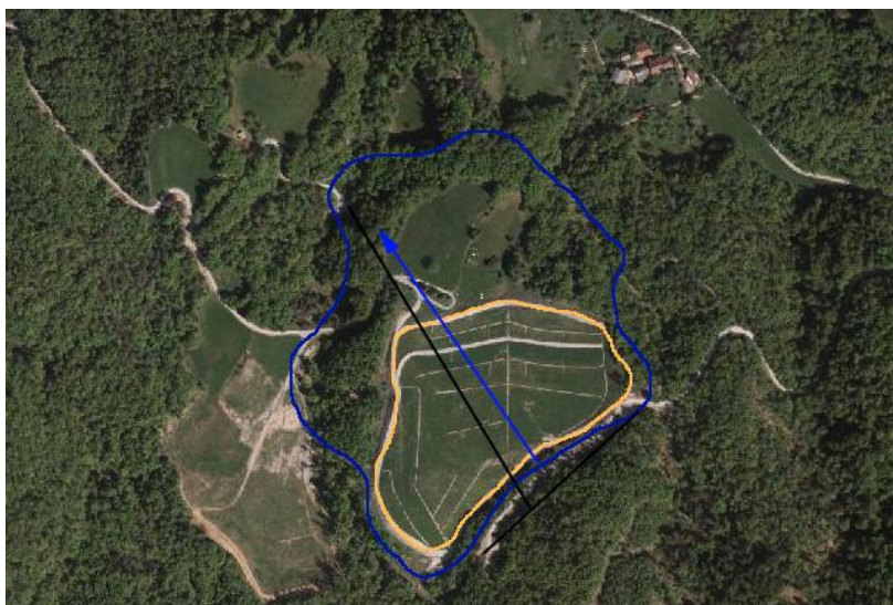
Slika 1: Prikaz odlagališča Boršt po končani sanaciji
