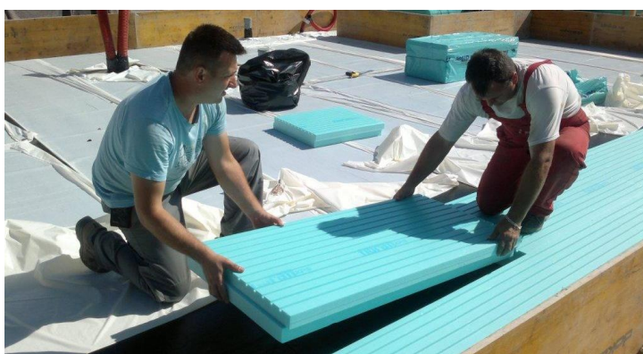
Slika 3: Polaganje toplotne izolacije z utori (Fibran.si, 2014)
