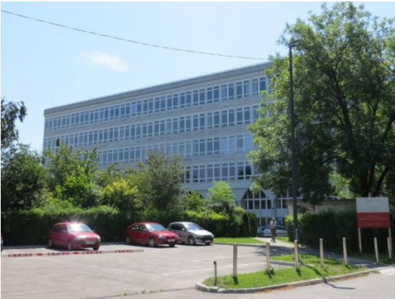
Slika 19: Fakulteta za gradbeništvo in geodezijo, severna stran
