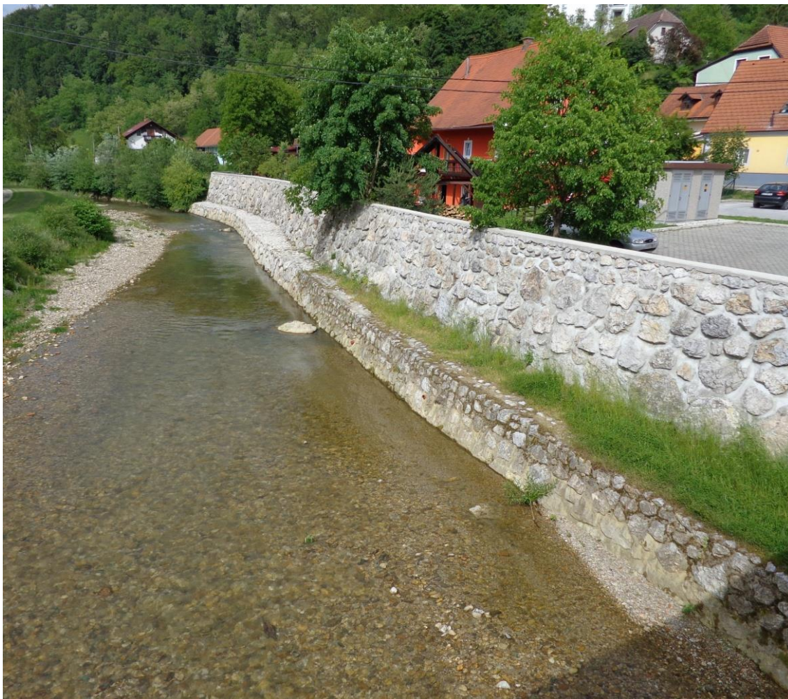
Slika 31: Protipoplavni zid v Vojniku
