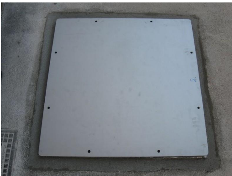
Slika 22: Tesnjenje pokrovov (PAL inženiring – Panelna zaščita WHS, 2014)
