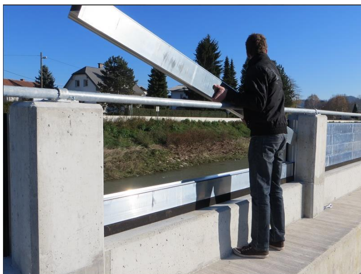
Slika 34: Postavitev lamelne zaščite IBS (PAL inženiring, 2014)
