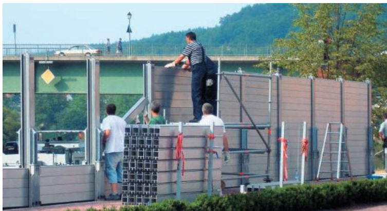
Slika 25: Prikaz postavljanja protipoplavne lamelne zaščite v Freudenbergu (PAL inženiring - Protipoplavna zaščita IBS, 2014)
