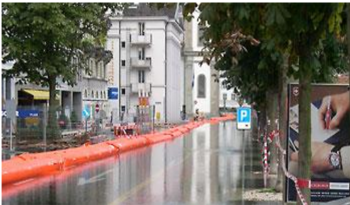
Slika 20: Primer uporabe Beaver cevnega sistema (PAL inženiring – Beaver cevni sistem, 2014)
