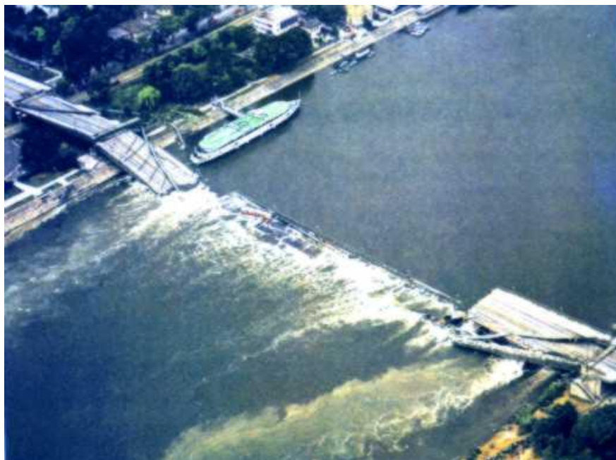
Slika 2.1: Porušen most Reichsbrücke na Dunaju 1. avgusta 1976 (Reichsbrucke, 2012)
