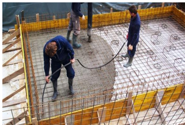
Slika 6: Vibriranje betona
