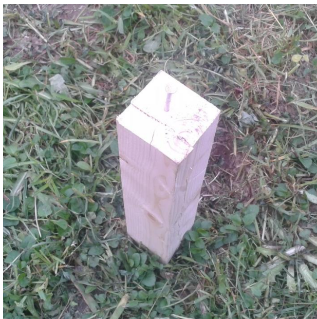
Slika 10: Detajlno zakoličena točka.
