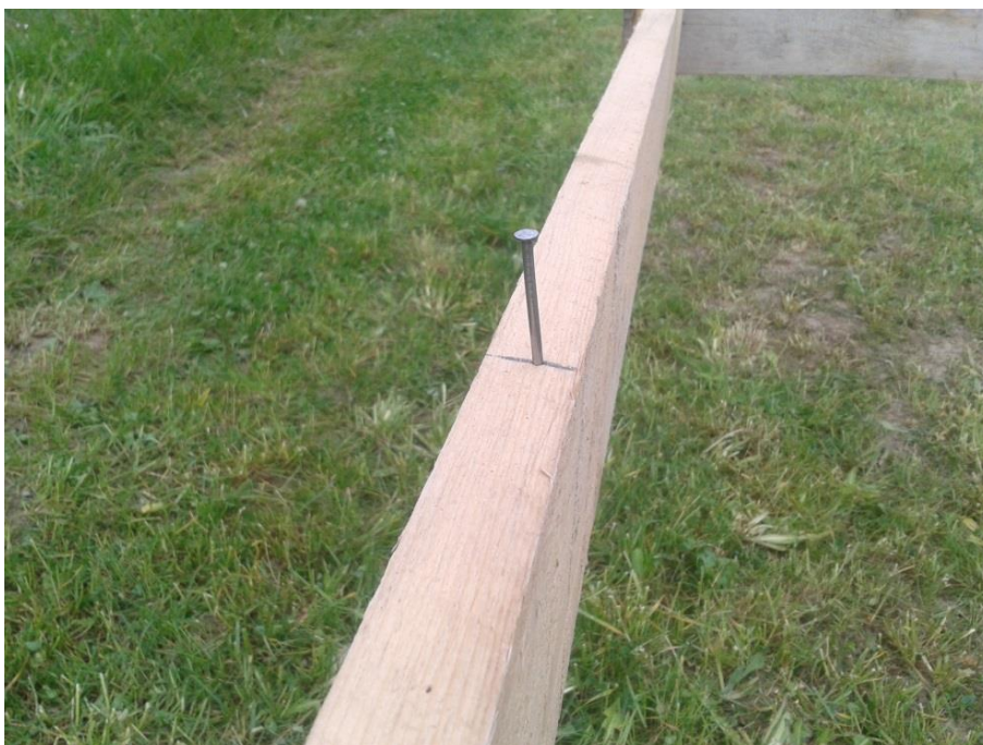
Slika 12: Os stanovanjske hiše označena na gradbenem profilu.
