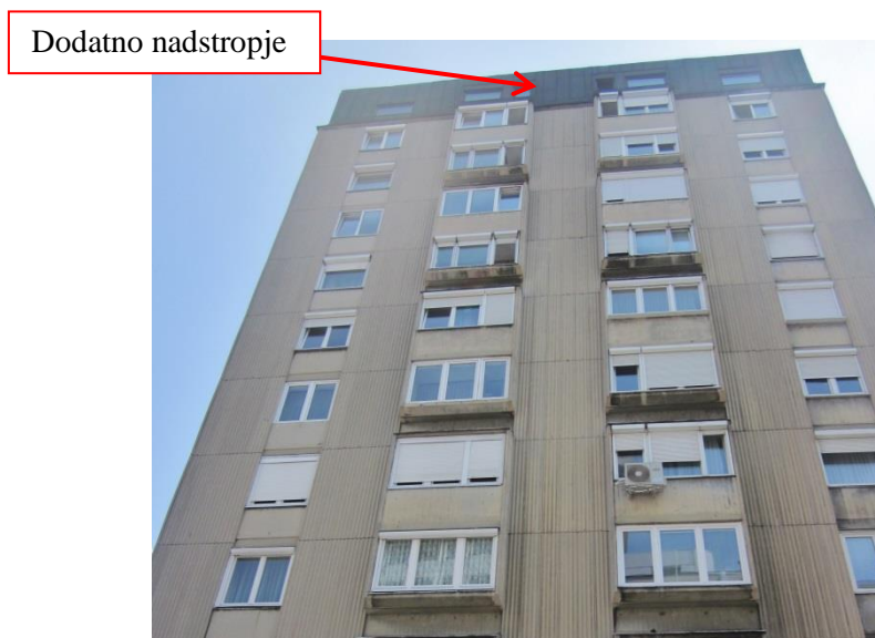
Slika 21: Dodatna izgradnja nadstropja na eni izmed stavb
