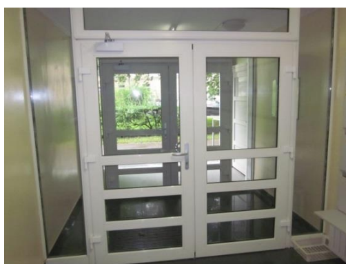
Slika 17: Zamenjana vhodna vrata
