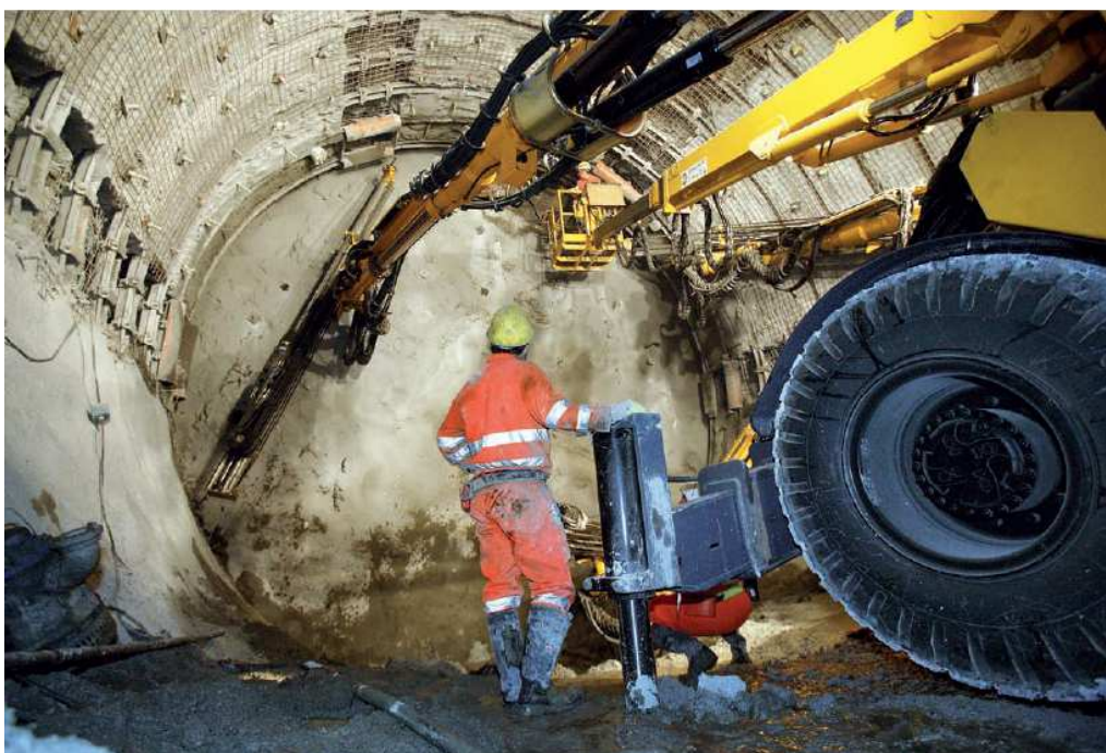
Slika 13: Vgrajevanje geotehničnih sider (vir: Kolić, D. (ur.), Likar, J. (ur.) 2011.)
