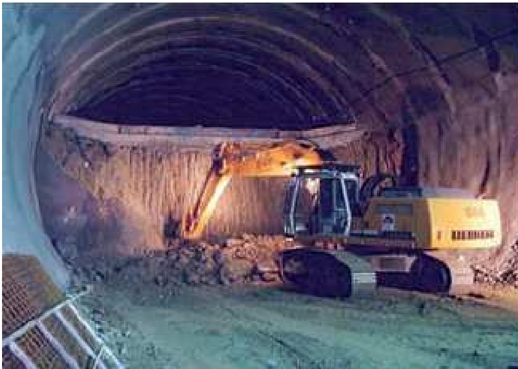
Slika 12: Izkop stopnice (vir: Kolić, D. (ur.), Likar, J. (ur.) 2011.)
