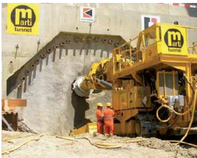
Slika 8: Stroj s premično glavo za vrtanje (vir: Kolić, D. (ur.), Likar, J. (ur.) 2011.)
