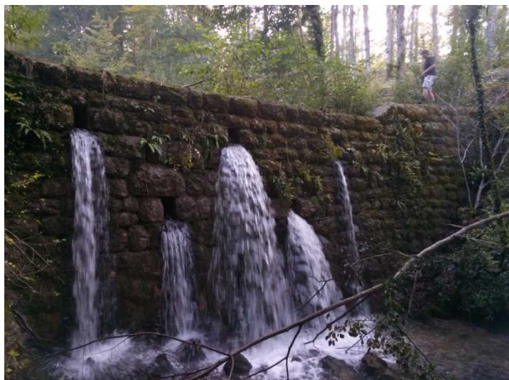
Slika 3: Pregrada na profilu vodotoka ob vznožju hriba
