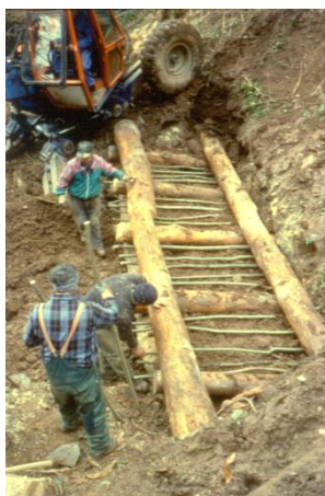
Slika 28: Lesena kašta s potaknjenci med gradnjo (Vir: Progetto F.R.A.N.E., 2005)
