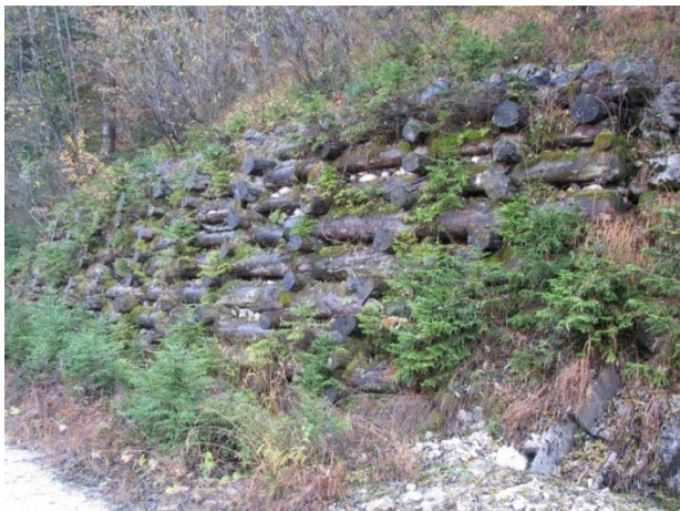
Slika 26: Porasla lesena kašta (kranjska stena) (Avtor: Zakotnik)
