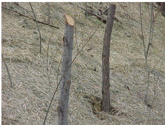
Slika 20: Vrbovi potaknjenci (Vir: NCHRP, 2005)
