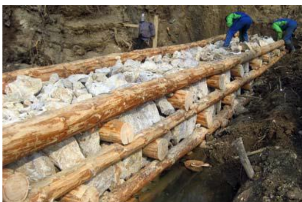
Slika 30: Gradnja lesene kašte (Avtor: Alen Muminovič)
