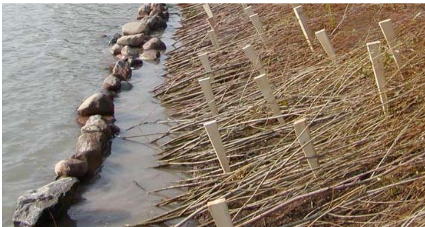
Slika 12: Vgradnja vrbovega popleta (Vir: NCHRP, 2005)
