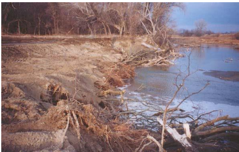
Slika 8: Vgrajena zaščita s hlobovino (Vir: NCHRP, 2005)
