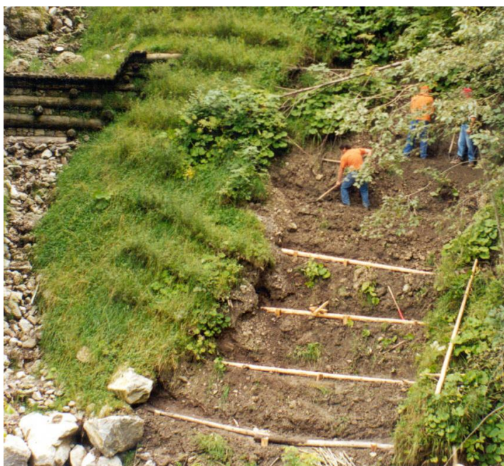
Slika 39: Kordonska zasaditev (Vir: Progetto F.R.A.N.E., 2005)
