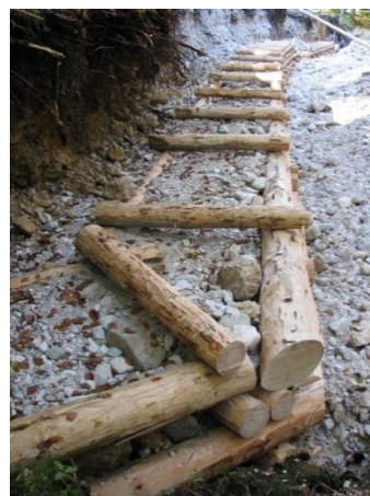
Slika 29: Gradnja lesene kašte (Avtor: Zakotnik)
