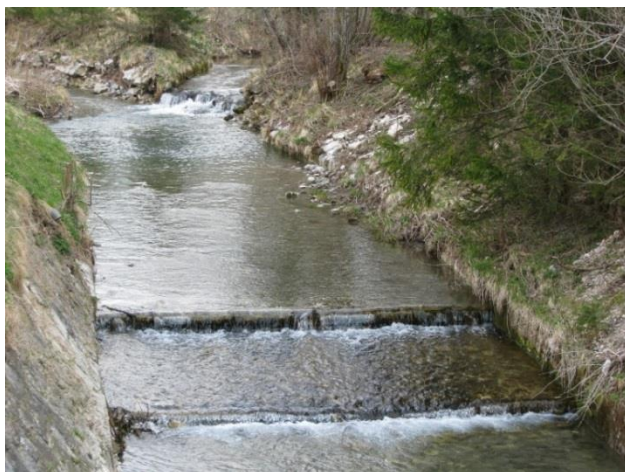
Slika 1: Pragovi na Jezernici (Avtor: Zakotnik)
