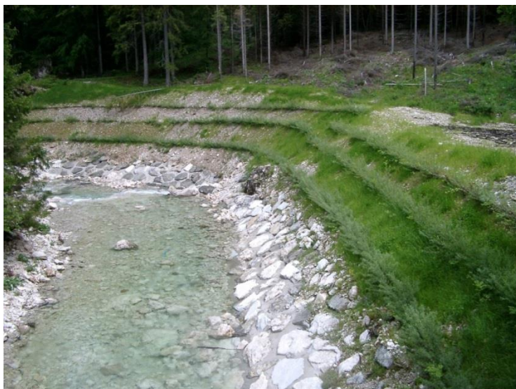
Slika 34: Zaščita brežine z živimi ščetkami (Avtor: Zakotnik)
