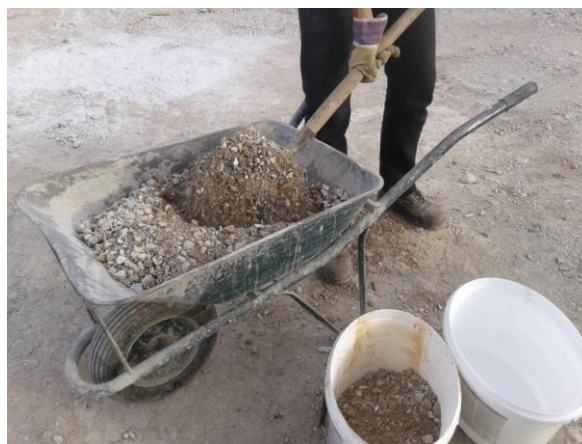
Slika 6: Nalaganje presejanega materiala
