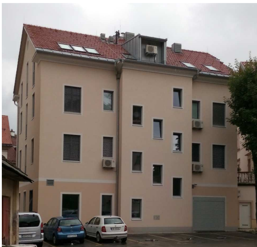
Slika 4: Objekt Vila Treven, SV del fasade (Lasten vir, 2014)
