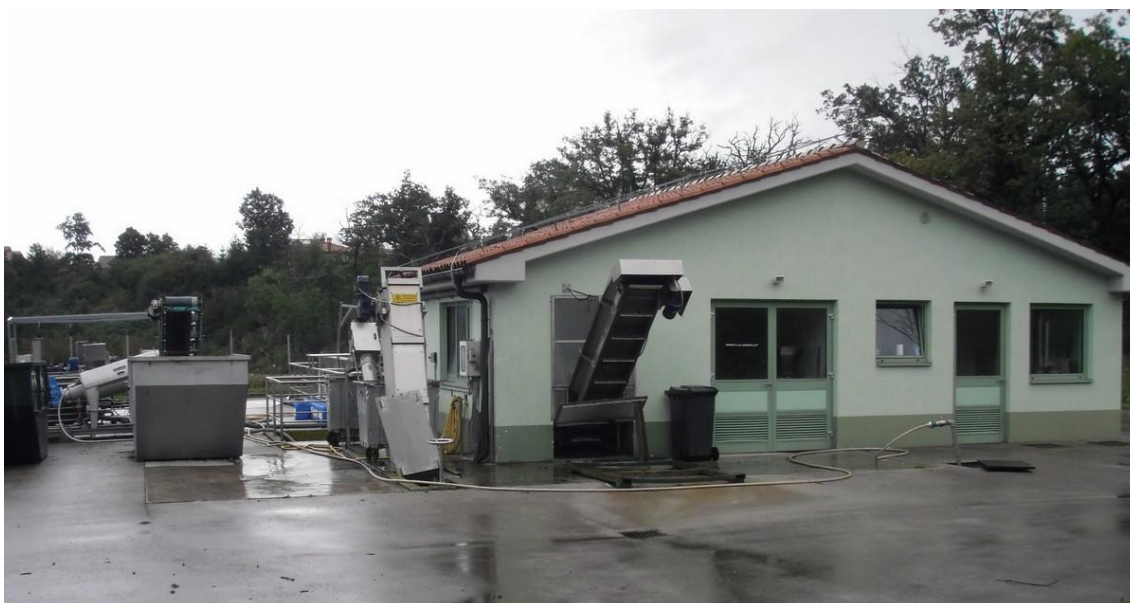
Slika 11: Čistilna naprava Divača
