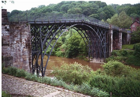
Slika 2: Prvi litoželezni most na svetu – Iron Bridge [4]
