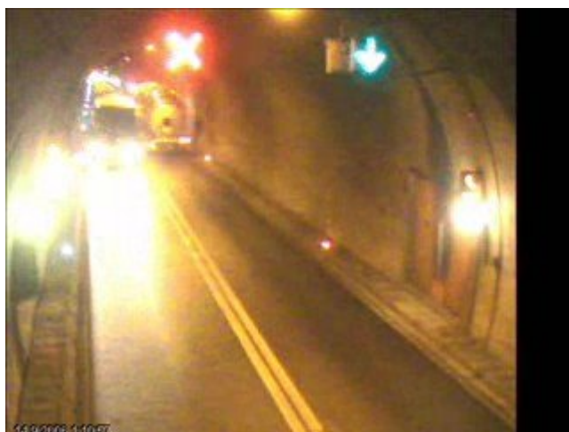
slika 62: Predor Mala Kapela
