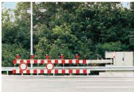
slika 55: primer izvedbe polzapornice
