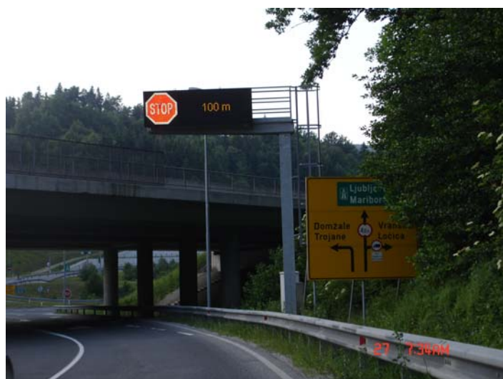
slika 23: SPIS na konzolnem nosilcu
