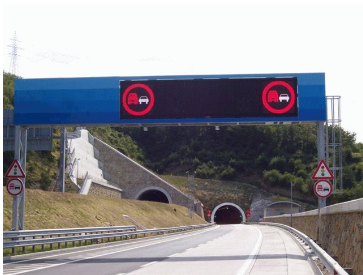
slika 24: SPIS preko celotnega cestišča
