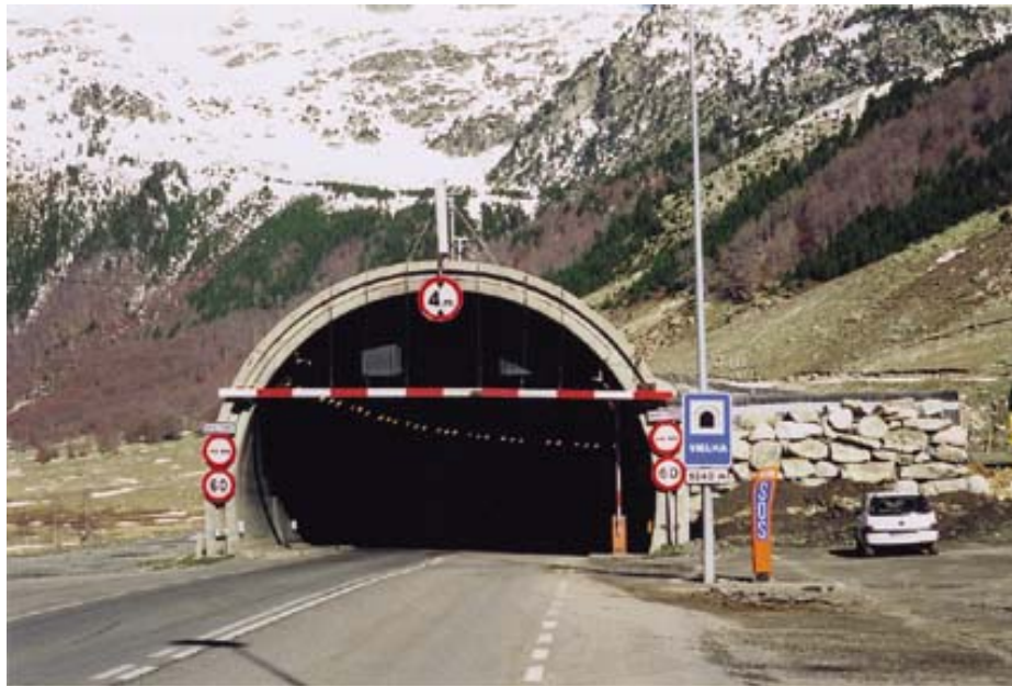
slika 49: kontrola višine na samem portalu predora v Avstriji
