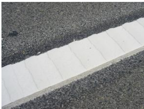
slika 58: Ropotno-dežna črta pred tunelom Karavanke
