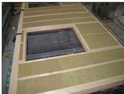
Slika 4 – Osnovna konstrukcija stene z izolacijo [1]
