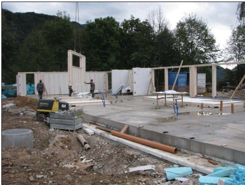
Slika 1 - Montaža hiše - panelni sistem [1]
