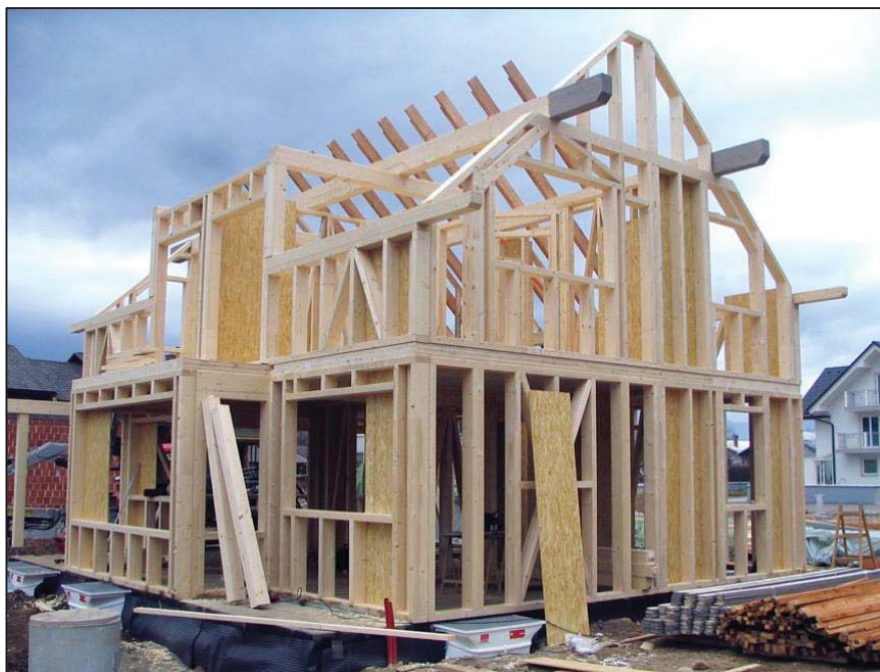
Slika 2 - Montaža hiše - skeletni sistem [6]
