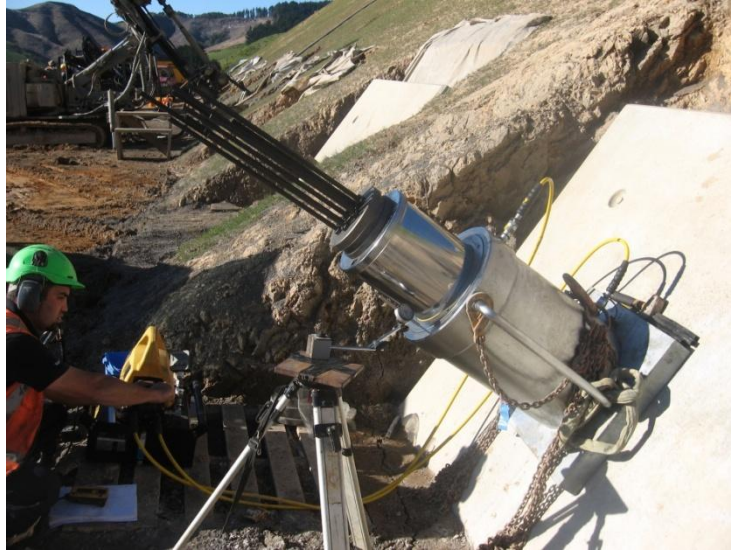
Slika 11: Napenjanje geotehničnega sidra (kontrolno sidro [8]).
