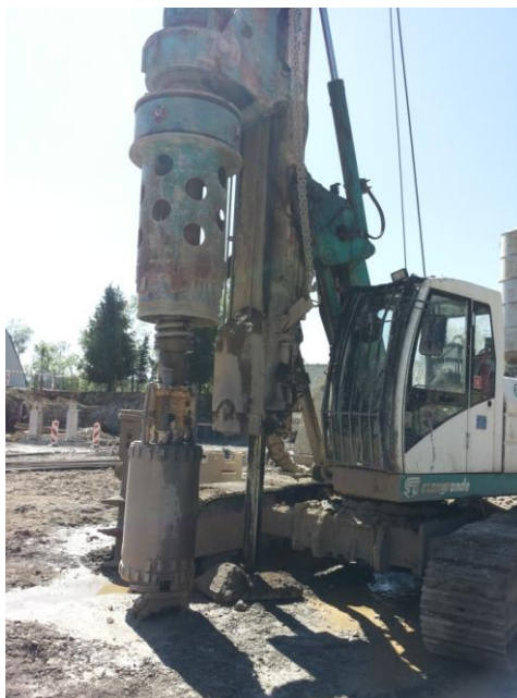
Slika 10: Stroj za gradnjo pilotov (Oblak, A.).
