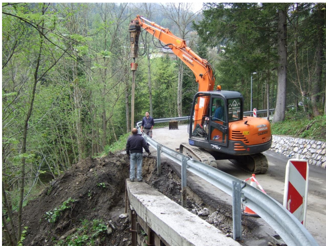
Slika 2: Zabijanje začasnih jeklenih profilov (Oblak, S.).
