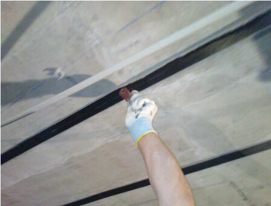
Slika 6: Vgradnja karbonskih lamel – valjanje za iztisnitev lepila (ISA Mernik – Investicije in sanacije)
