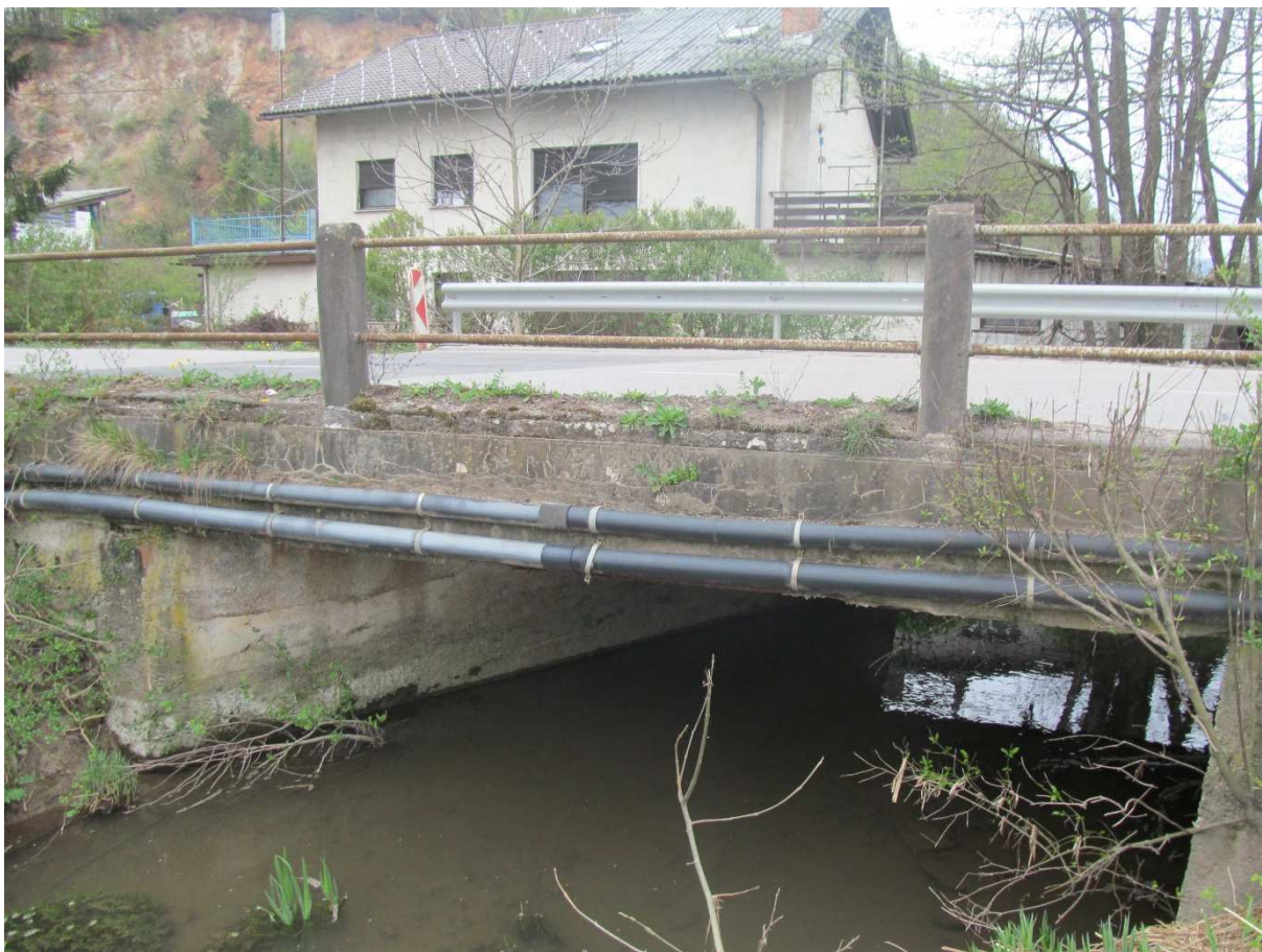
Slika 3: Objekt (Slika narejena med pregledom leta 2013)
