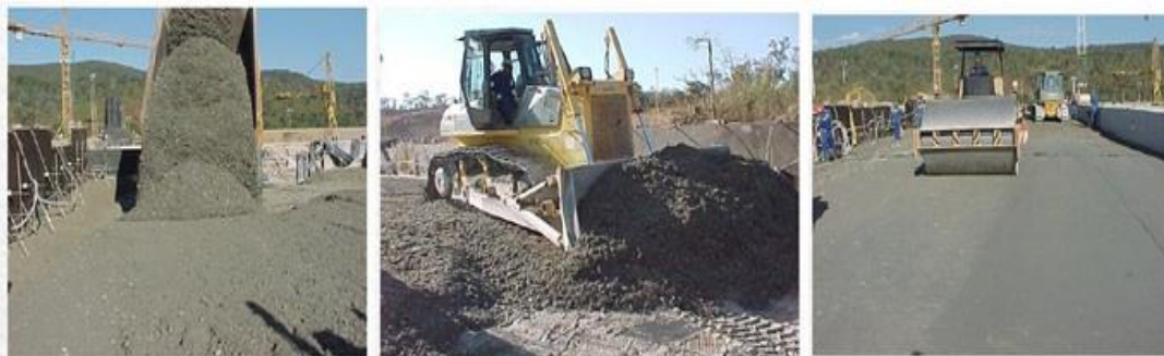
Slika 1: Uporaba mehanizacije pri gradnji pregrad iz valjanega betona; iz leve proti desno: raztros mešanice s kamioni prekucniki, razstiranje z buldožerji in zgoščevanje s kompakcijskimi valjarji [1]
