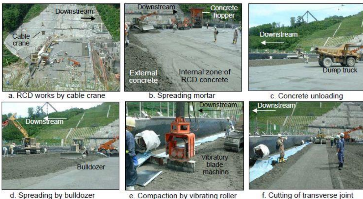
Slika 8: Postopki gradnje pregrade iz valjanega kompaktiranega betona: a. transport z žerjavom, b. nanos veziva/malte, c. raztovarjanje betona, d. planiranje oz razširjanje z buldožerji, e. zbijanje z vibracijskim valjarjem, f. rezanje delovnih stikov [6]
