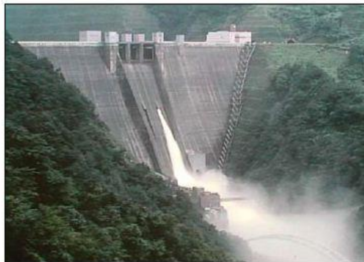
Slika 4: Pregrada Miyagase (Japonska)- največja do sedaj zgrajena RCD pregrada [6]
