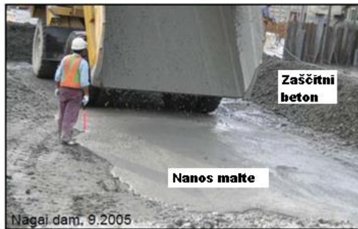
Slika 7: Razstiranje in nanos vezivnega sredstva oziroma malte (Nagai pregrada, Japonska) [6]
