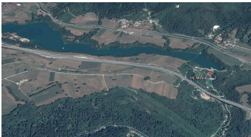
Slika 19: Zadrževalnik z označenim mestom pregrade Moste (Vir: Google Maps https://maps.google.com/ )
