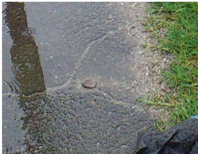
Slika 9: Stabilizacija poligonskih točk – točka 6000
