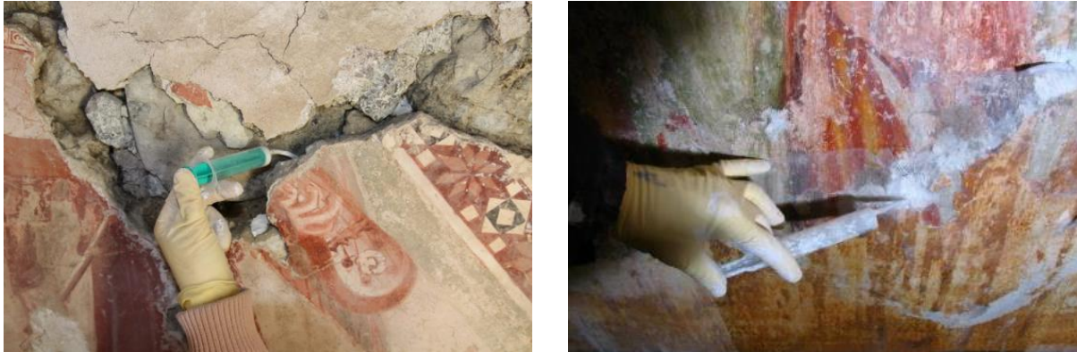
Slika 3: Prikaz injektiranja pri zapolnjevanju razpok in zračnih žepov z injekcijskimi mešanicami (avtor slike: Anita Kavčič Klančar)
