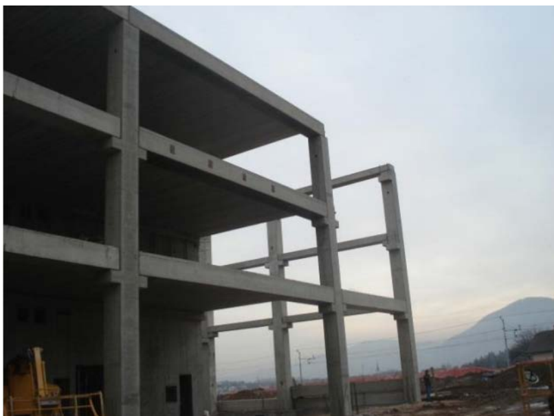
Slika 2.1: Montažni armiranobetonski okvir (SGP POMGRAD, 2013)
