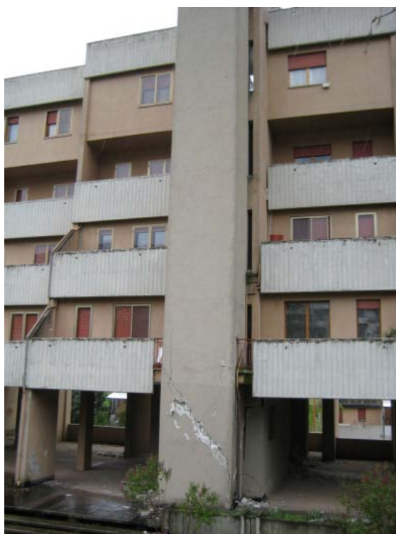
Slika 2.3: Pojav močne poškodovanosti objekta zaradi efekta mehke etaže (Dolšek, 2014)
