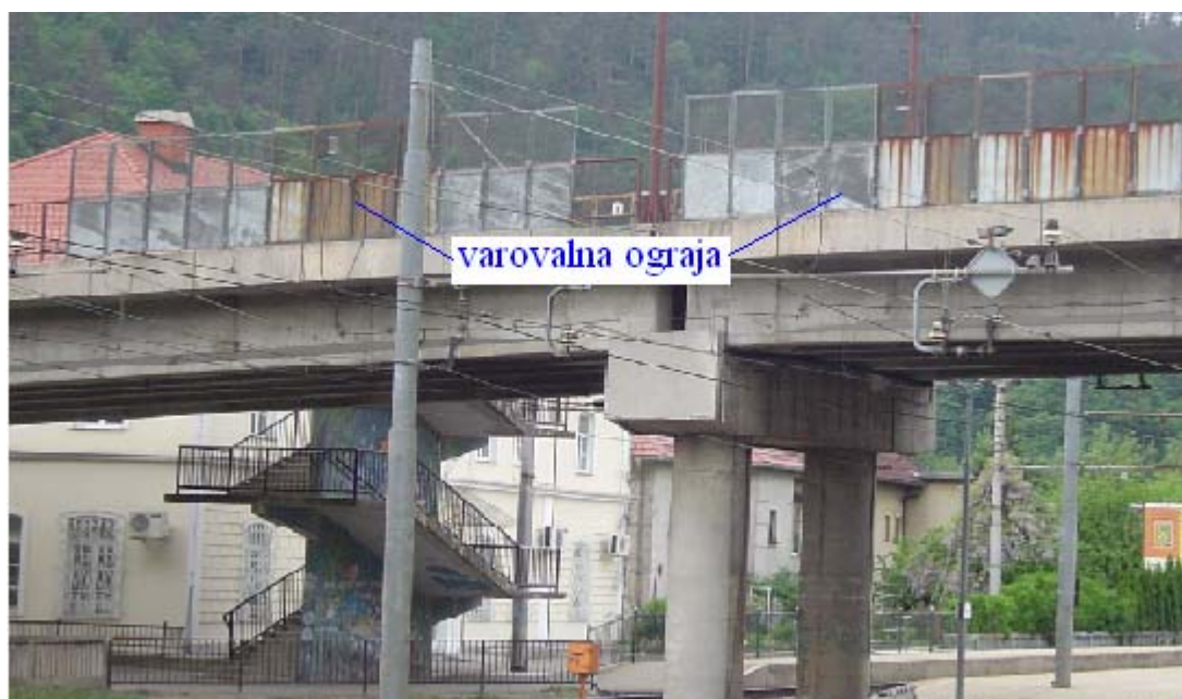
Slika 52: Varovalna ograja na nadvozu preko železniške proge
