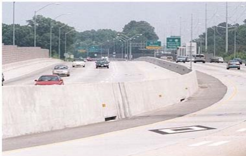
Slika 46: Betonska varnostna ograja s konstantnim naklonom
