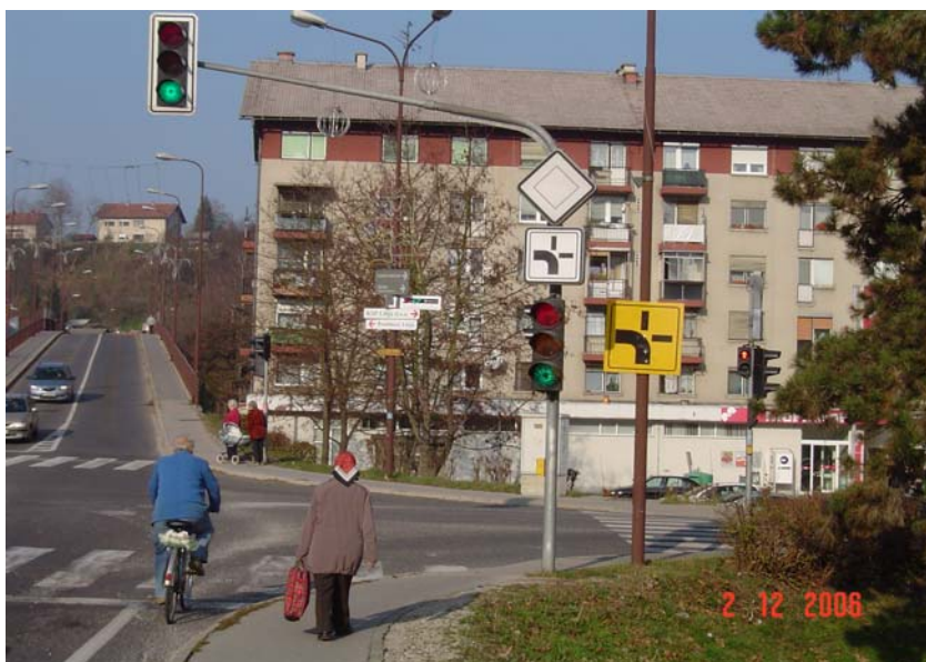
Slika 26: Montaža semaforja na usločenem drogu skupaj z znakom za prednost
