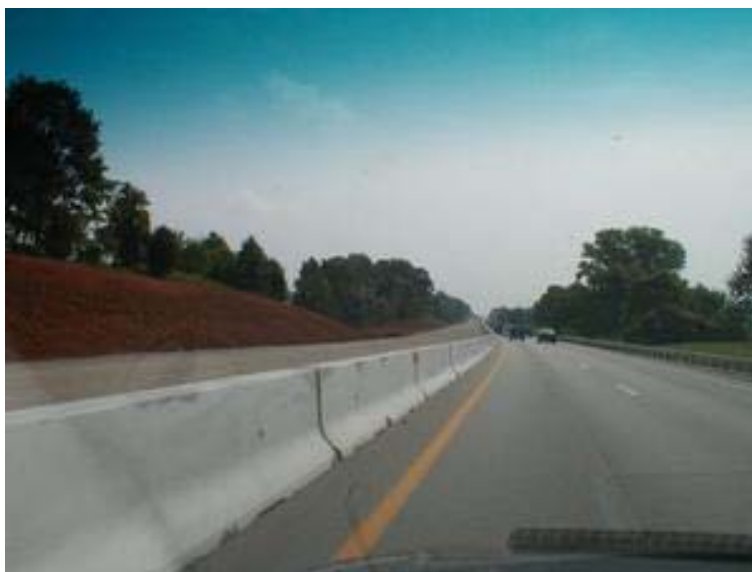
Slika 44: » New Jersey « betonska varnostna ograja
