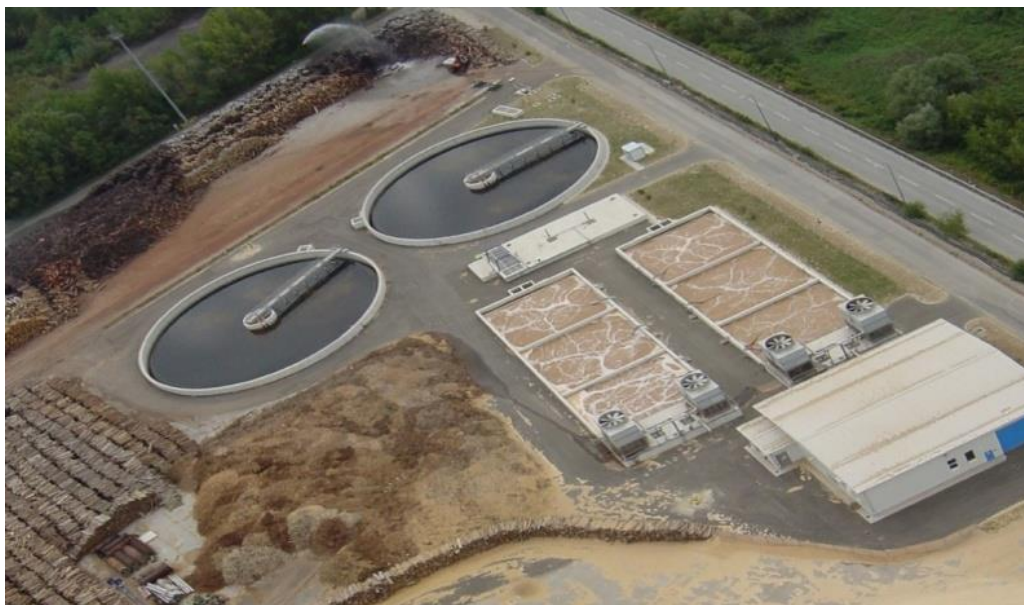
Slika 9: Čistilna naprava pri tovarni Vipap [27]
