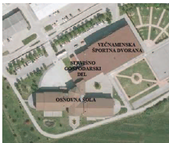
Slika 8: Ortofoto posnetek stavbe z vpisanimi sklopi (Vir: [16])
