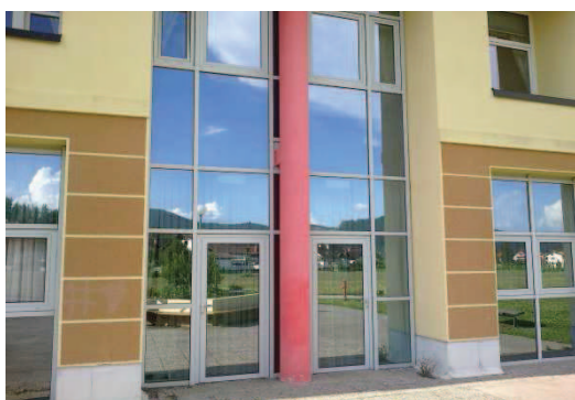
Slika 5: Polstrukturna fasada (knjižnica)
