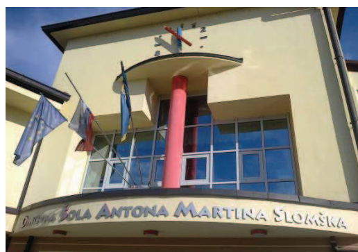
Slika 6: Polstrukturna fasada (zbornica)
