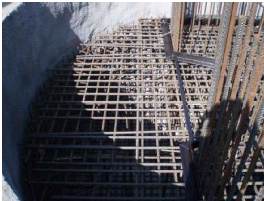
Slika 5.2: Pravilno položena in pregledana armatura (Vir: Lasten arhiv)
