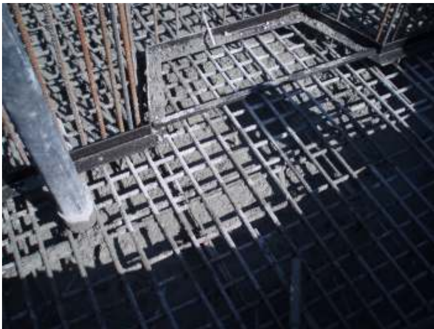
Slika 5.3: Vgrajevanje betona, mesto odvzema vzorca (Vir: Lasten arhiv)
