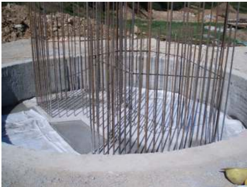
Slika 5.5: Nega betona po končanem vgrajevanju (Lasten arhiv)
