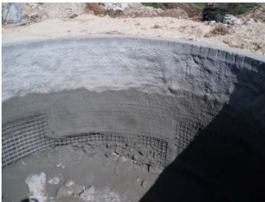
Slika 5.1: Predpriprava vodnjaka (Vir: Lasten arhiv)
