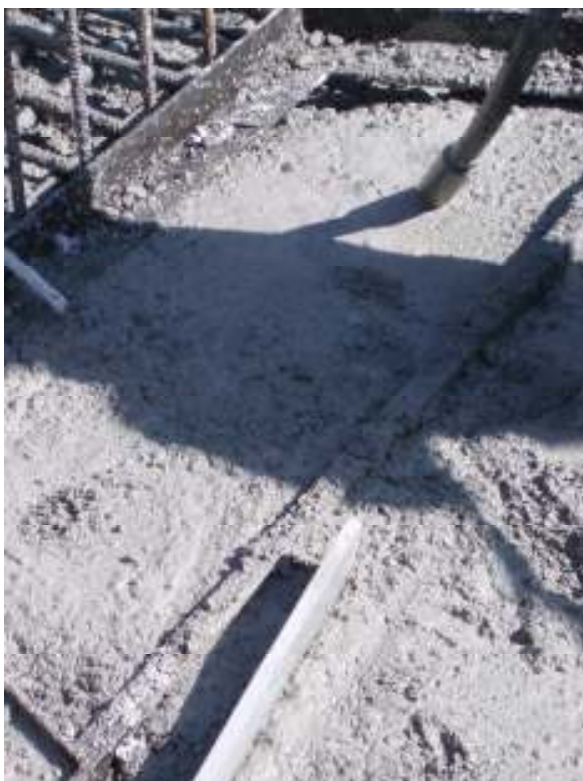
Slika 5.4: Vibriranje betona z vibracijsko iglo (Vir: Lasten arhiv)
