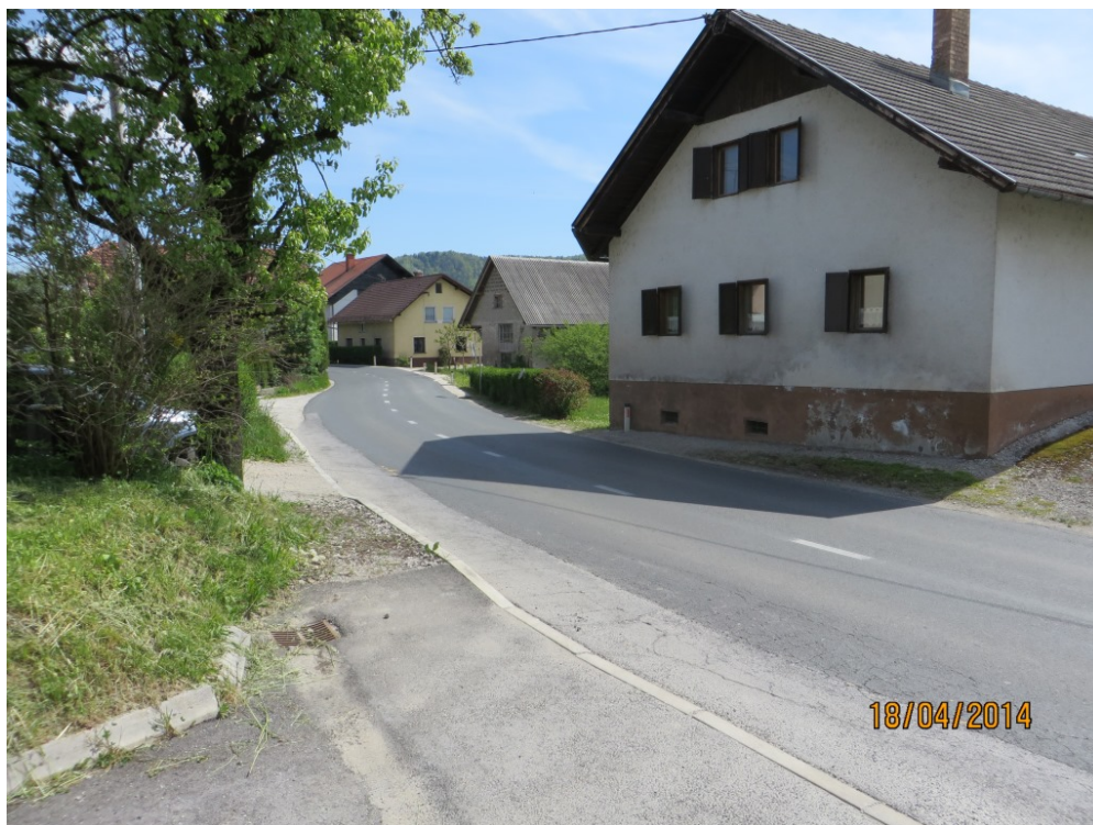
Slika 7: Slika zaključka pločnika sredi naselja in bližina pozidave objektov
